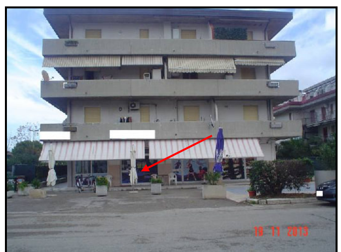
Foto 6 – Veduta del fabbricato con individuazione del locale commerciale
