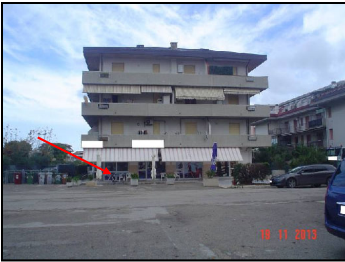
Foto 1 – Veduta del fabbricato con individuazione del locale commerciale
