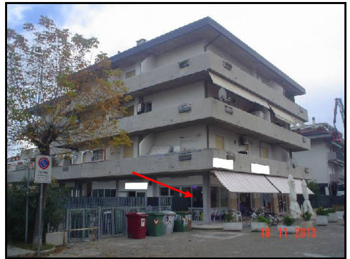
Foto 2 – Veduta del fabbricato con individuazione del locale commerciale
