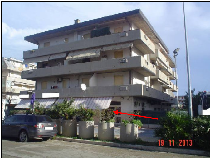
Foto 3 – Veduta del fabbricato con individuazione del locale commerciale
