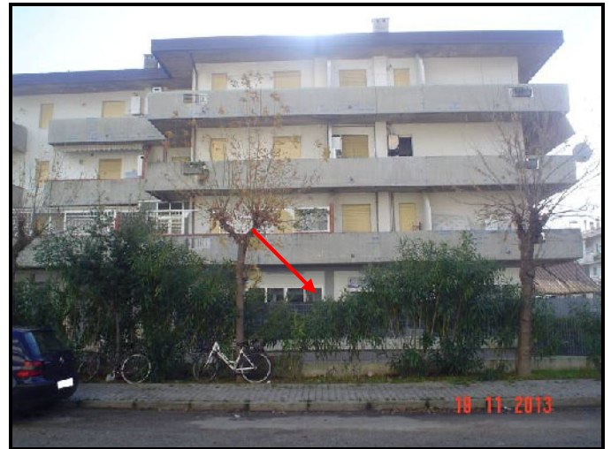
Foto 4 – Veduta del fabbricato con individuazione del locale commerciale
