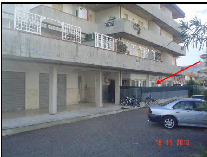
Foto 5 – Veduta del fabbricato con individuazione del locale commerciale
