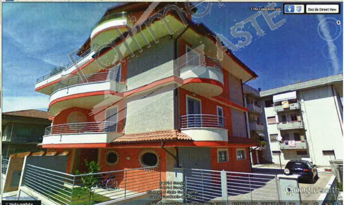
DOCUMENTO FOTOGRAFICO NR 13 Particella 2473 sub 7-13 Vista Esterna Fabbricato – Lato Est
