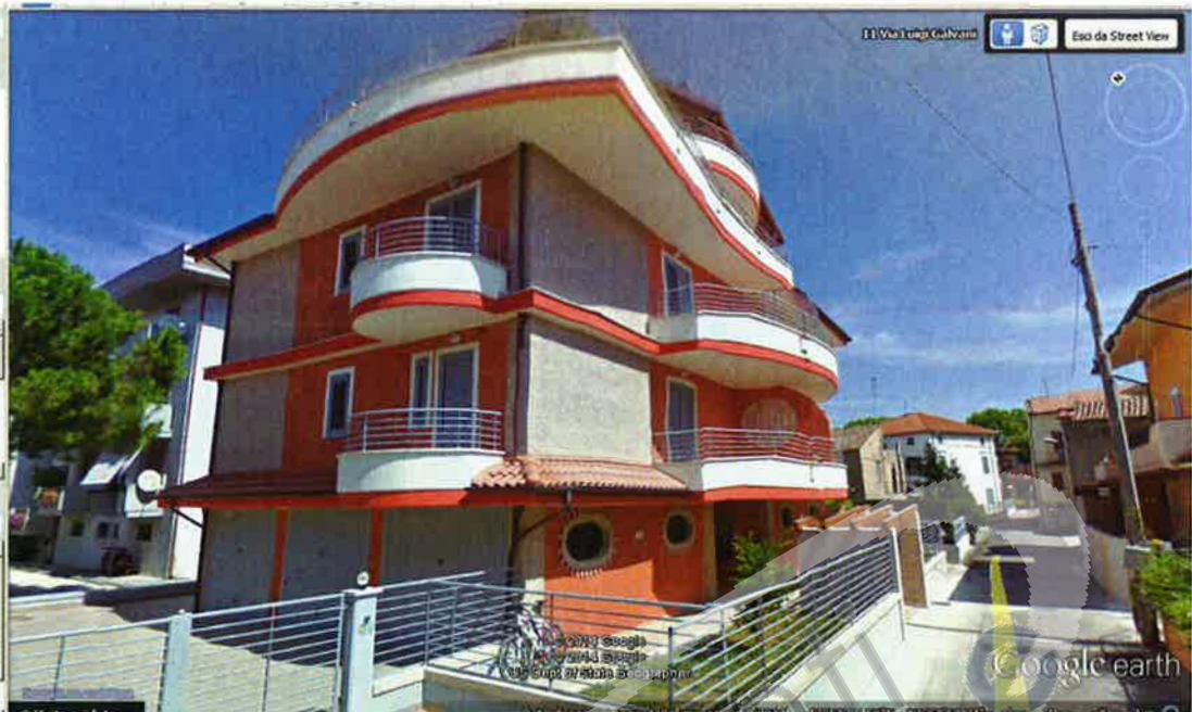
DOCUMENTO FOTOGRAFICO NR 13 Particella 2473 sub 7-13 Vista Esterna Fabbricato- Lato Ovest
