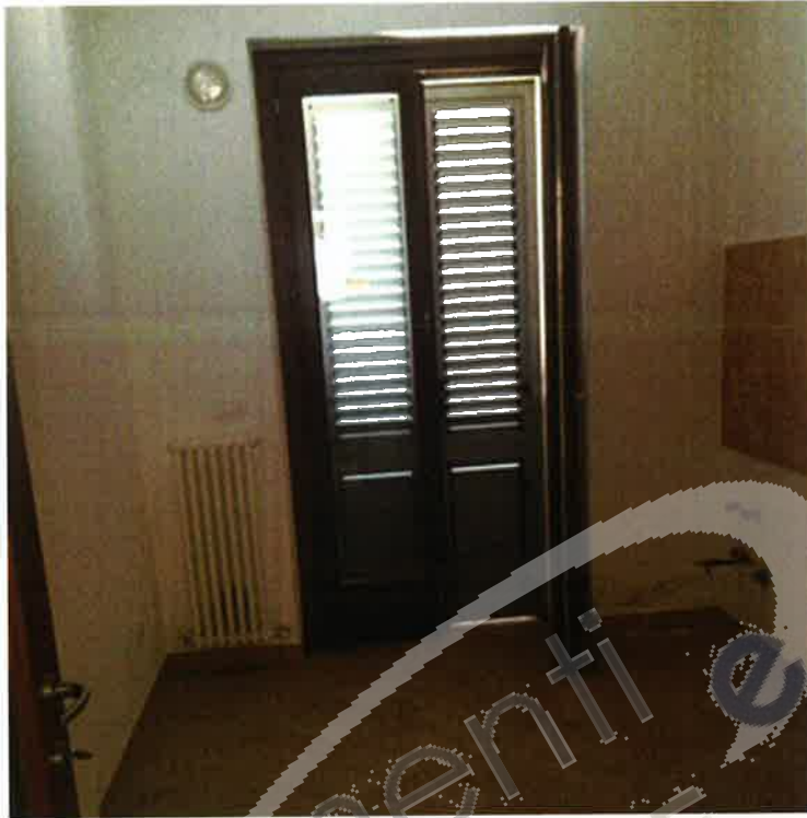
DOCUMENTO FOTOGRAFICO NR 3 Particella 2473 sub 13–Cucina Immobile
