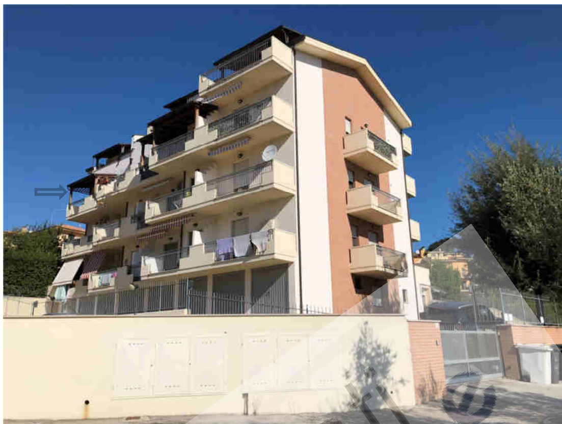
Foto n.3 – Vista lato sud palazzina
