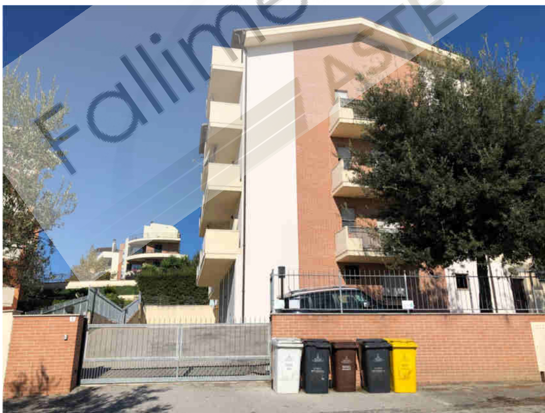
Foto n.2 - Ingresso Carrabile Condominio da Piazza Guido D'Arezzo
