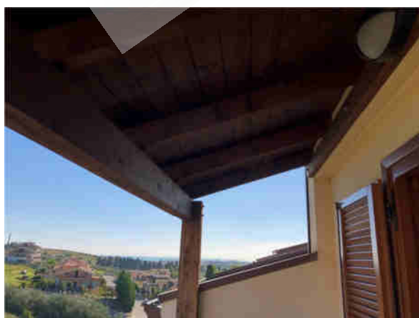
Foto n.21 – Tettoie a copertura dei balconi
