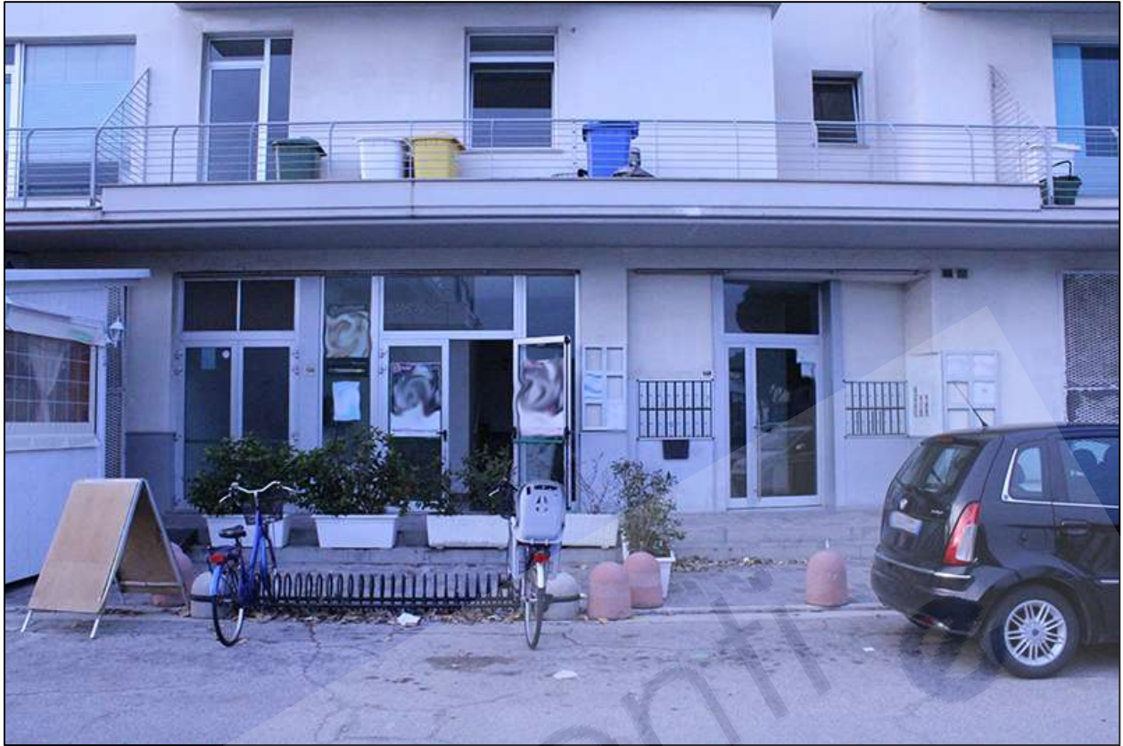
Foto n.3- Ingresso al vano scala lato sud
