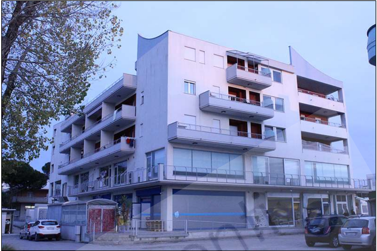
Foto n.1- Fabbricato lato nord-ovest
