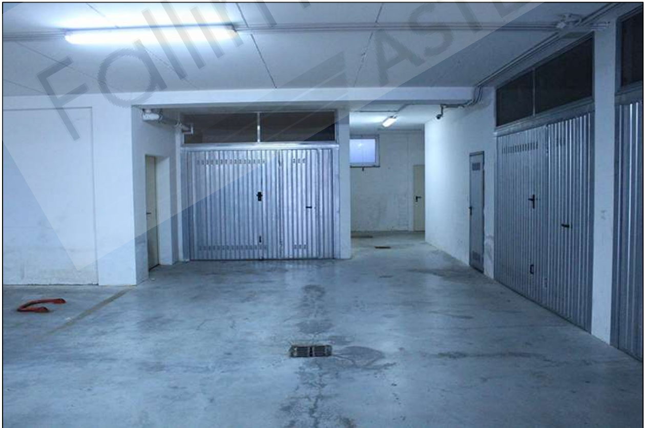
Foto n.6- Corsia condominiale piano S1
