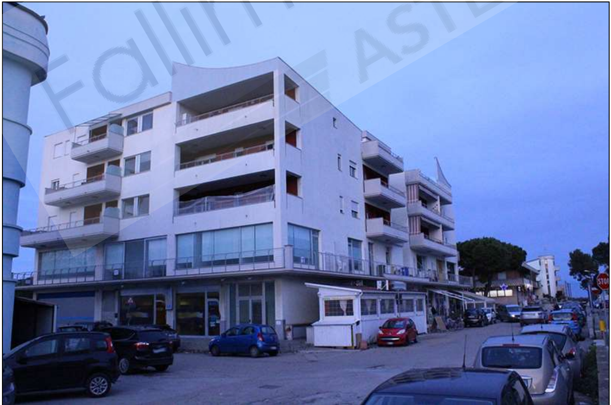
Foto n.2- Fabbricato lato sud-ovest
