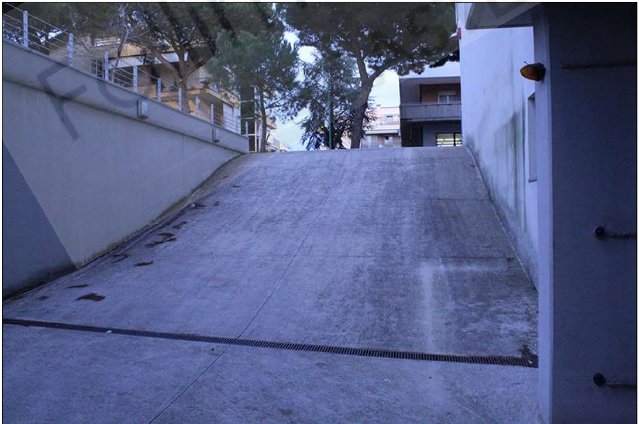
Foto n.12- Rampa carrabile al piano S1
