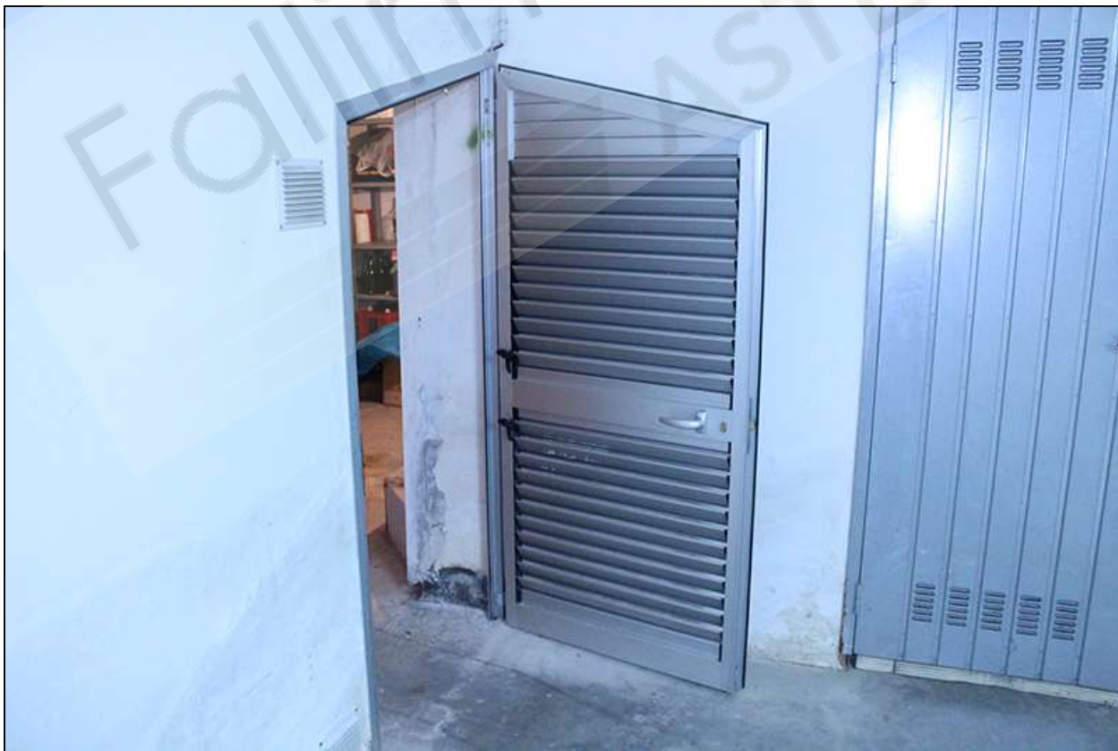
Foto n.8- Ingresso ripostiglio sub.24
