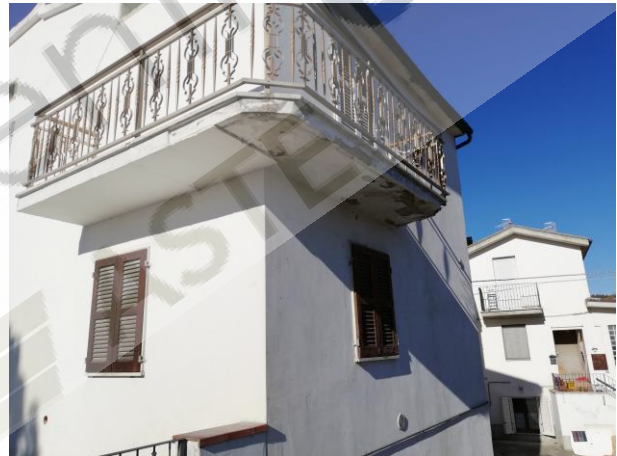
Foto 4a e 4b: fenomeni di carbonatazione sul balcone e sulla copertura, lesioni sulle murature;
