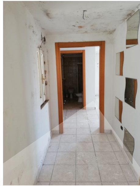
Foto 3a e 3b: tracce di intonaco proveniente dal solaio, presenza di umidità;
