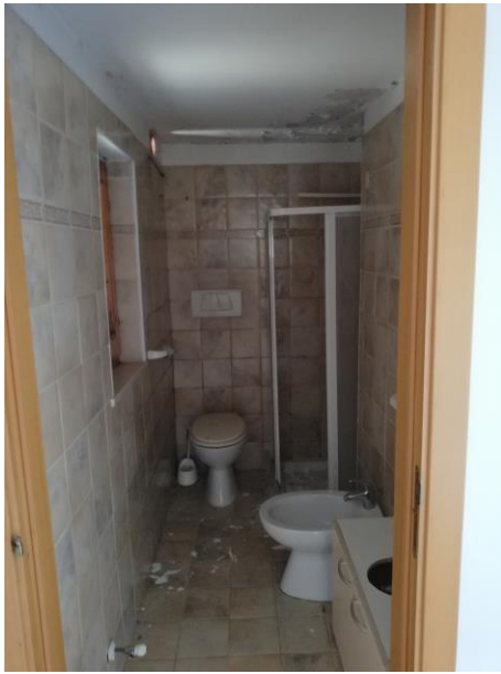
Foto 3a e 3b: tracce di intonaco proveniente dal solaio, presenza di umidità;
