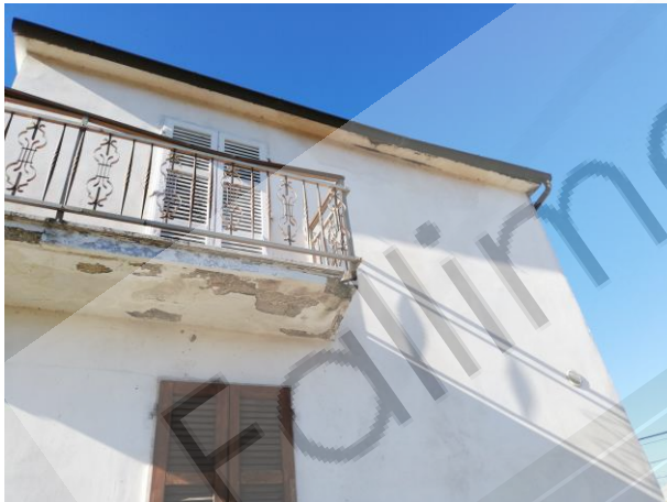
Foto 4a e 4b: fenomeni di carbonatazione sul balcone e sulla copertura, lesioni sulle murature;
