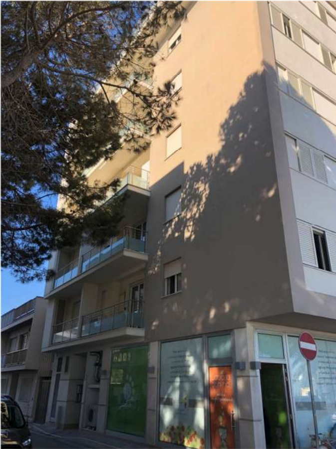
Foto n.1 – Vista palazzina Da Via Genzano
