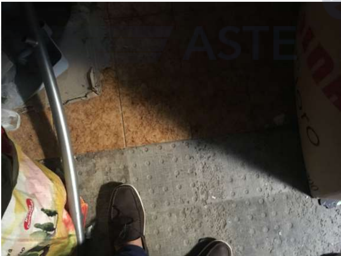
Foto n.18 – Vista interna Sub. 13
