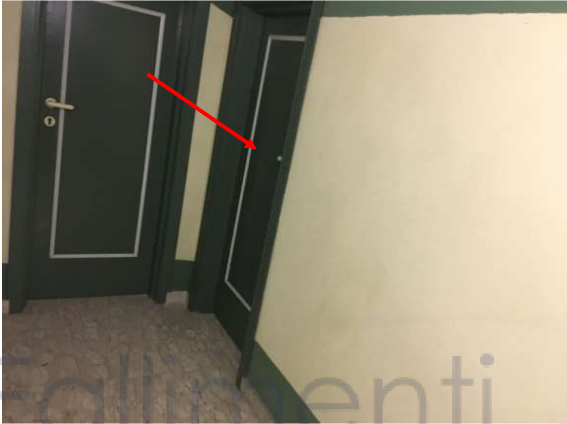
Foto n.13 – Portone d'ingresso Sub.13
