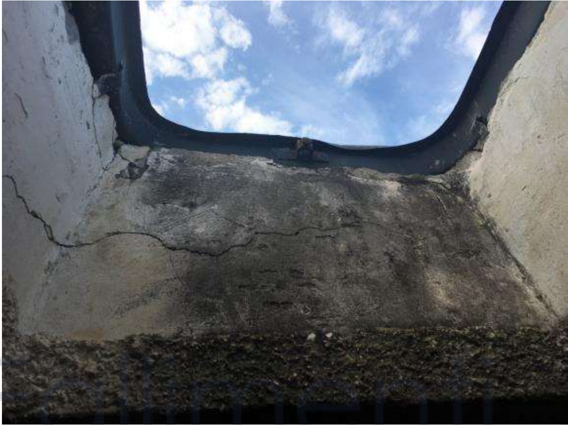
Foto n.21 – Vista interna Sub.26 – Lucernario
