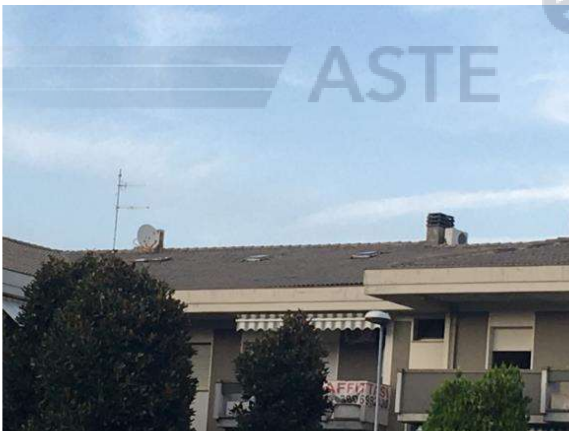
Foto n.4 – Vista esterna del fabbricato
