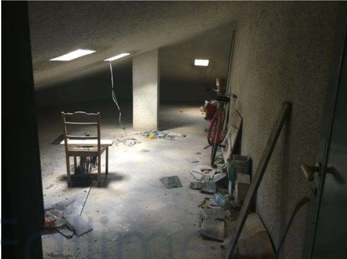
Foto n.11 – Vista interna Sub.26
