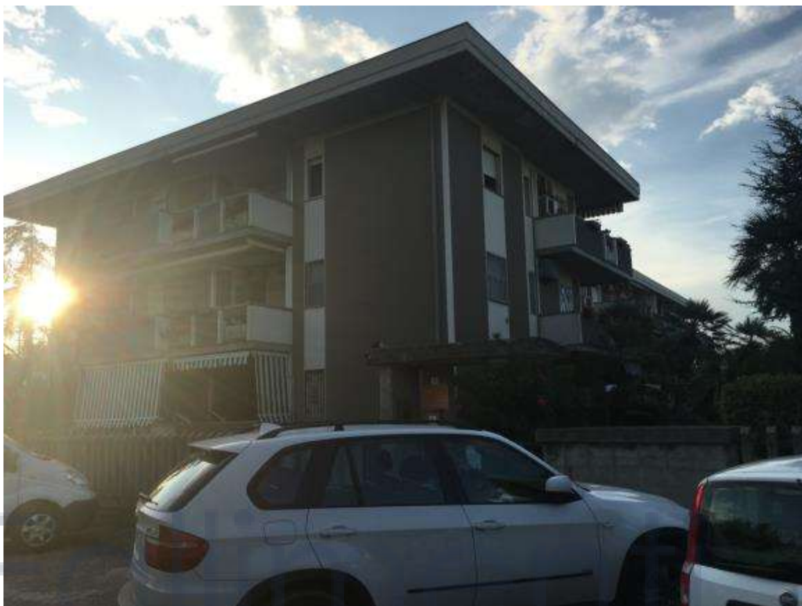
Foto n.3 – Vista esterna del fabbricato
