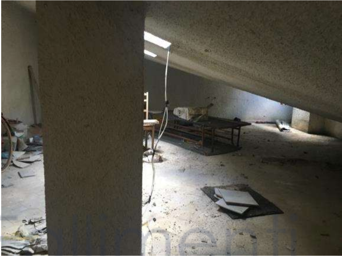
Foto n.17 – Vista interna Sub.26
