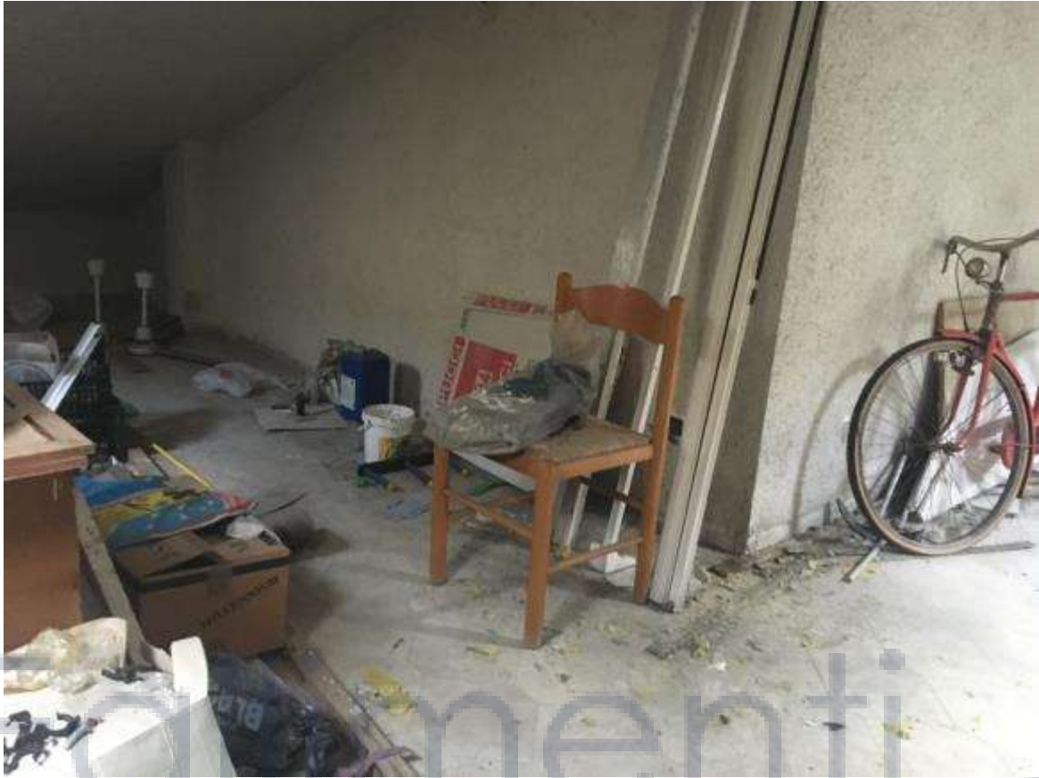
Foto n.15 – Vista esterna Sub.26
