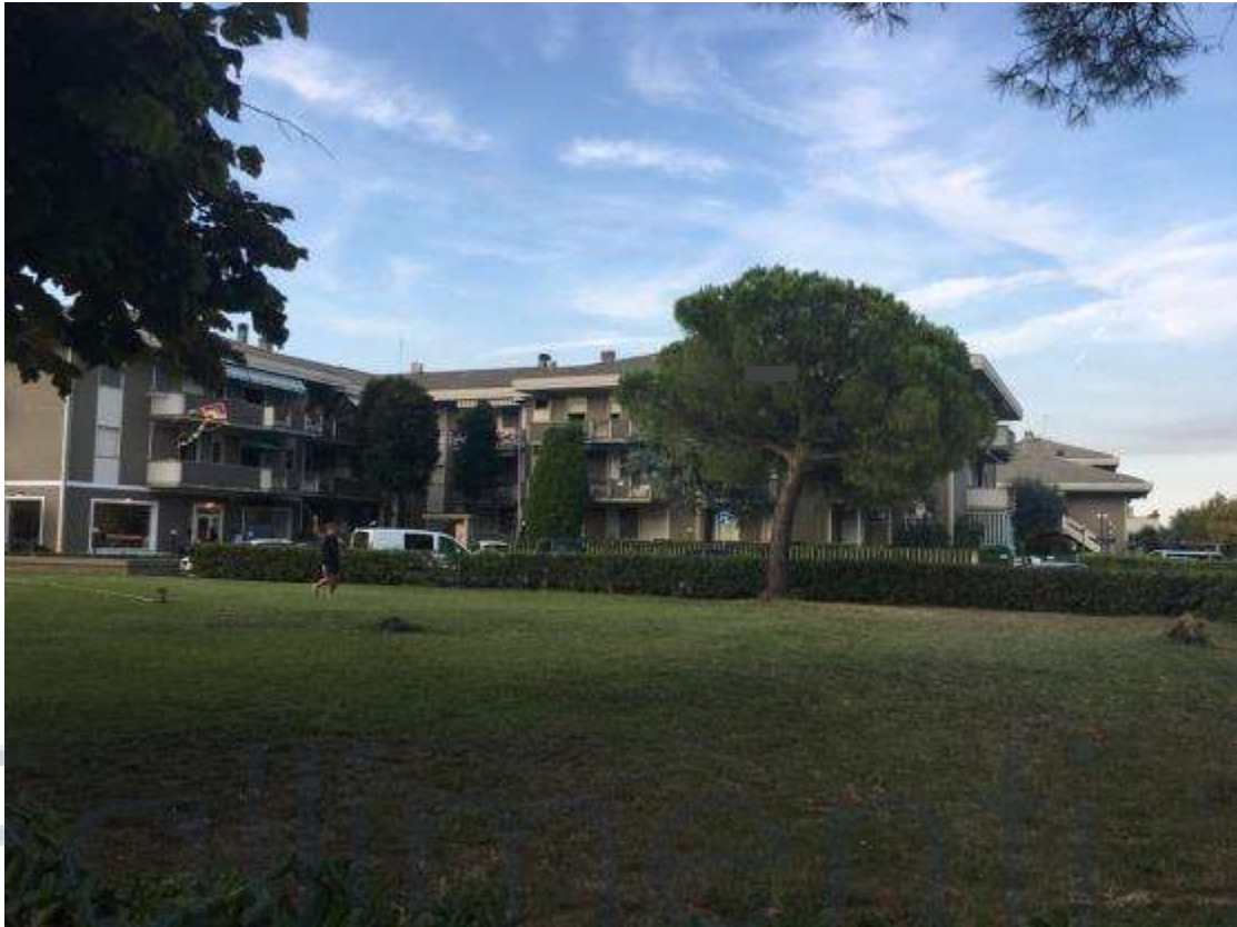
Foto n.1 - Vista esterna del fabbricato - Area pertinenziale
