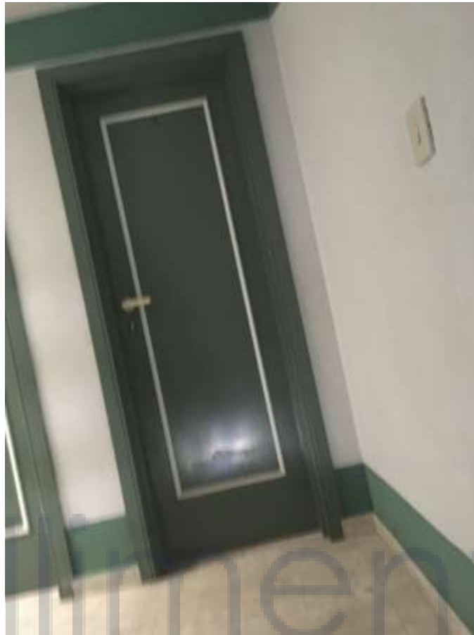
Foto n.11 – Porta d'ingresso al Sub.29
