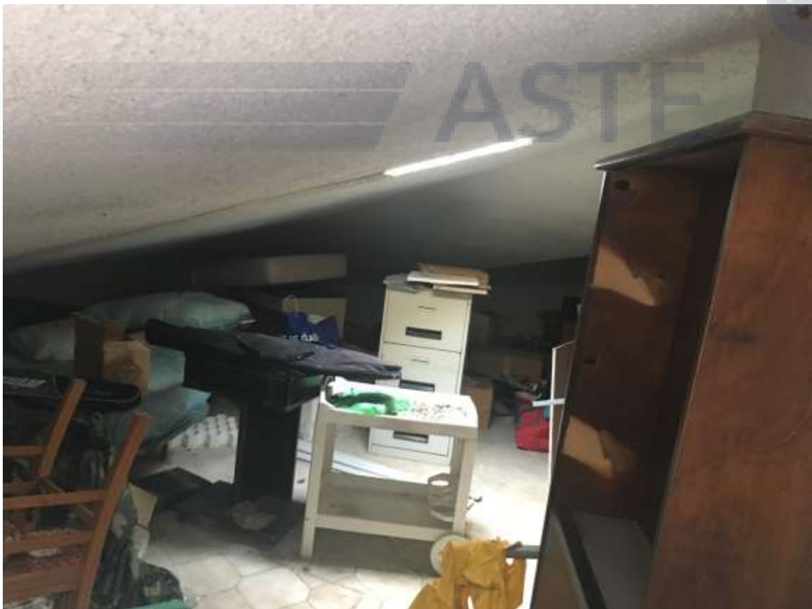
Foto n.14 – Vista interna Sub.29
