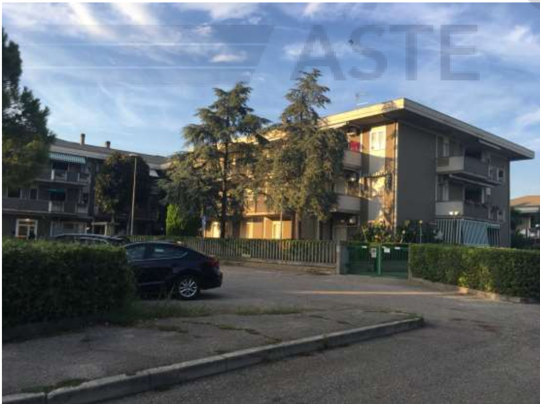
Foto n.2 – Vista esterna dell'edificio
