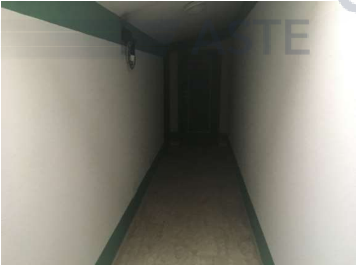
Foto n.12 – Corridoio verso Sub.26
