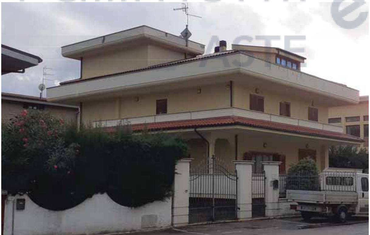
Foto n.2- Vista lato est
