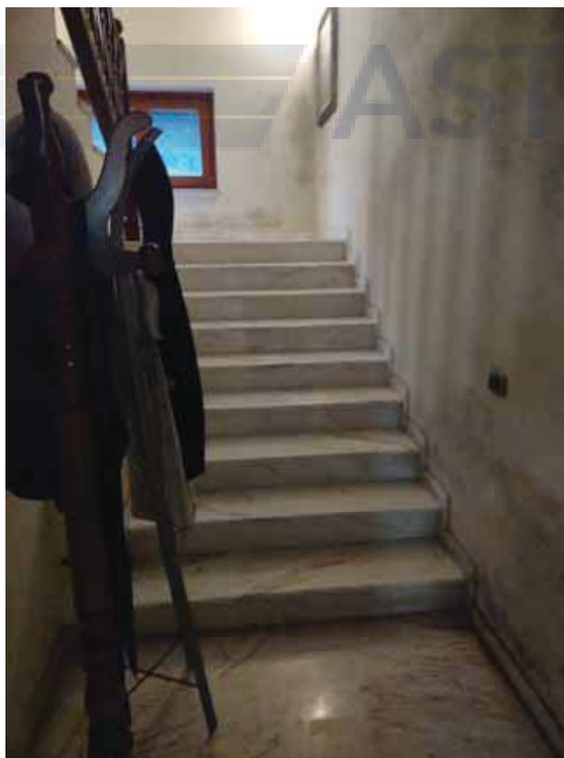
Foto n.4- Accesso al seminterrato
