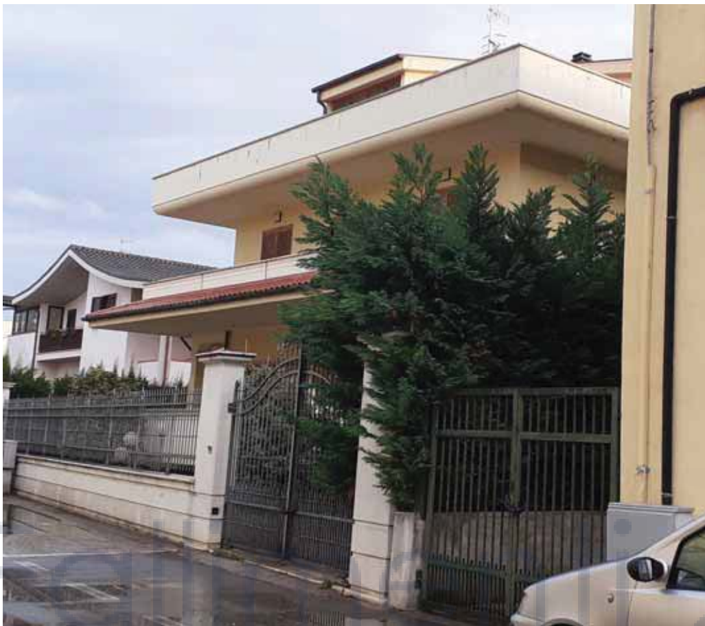
Foto n.3- Lato nord-ovest, con accesso al garage
