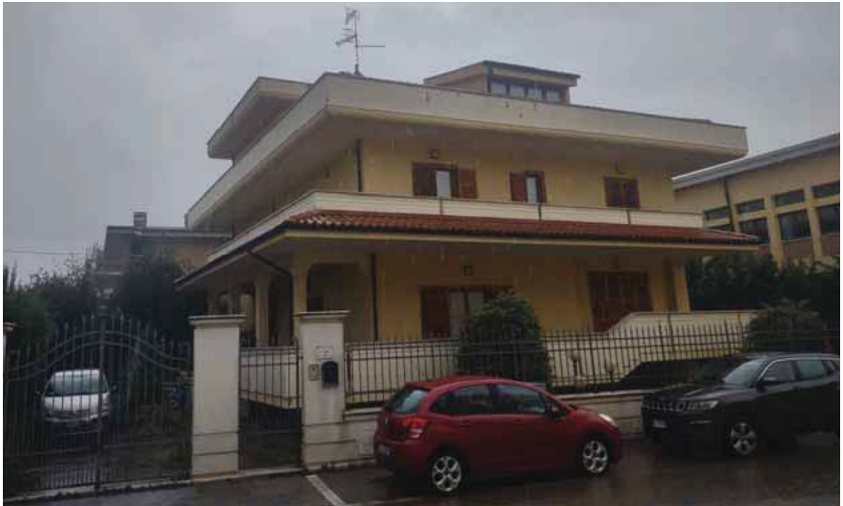
Foto n.1- Vista lato nord-est
