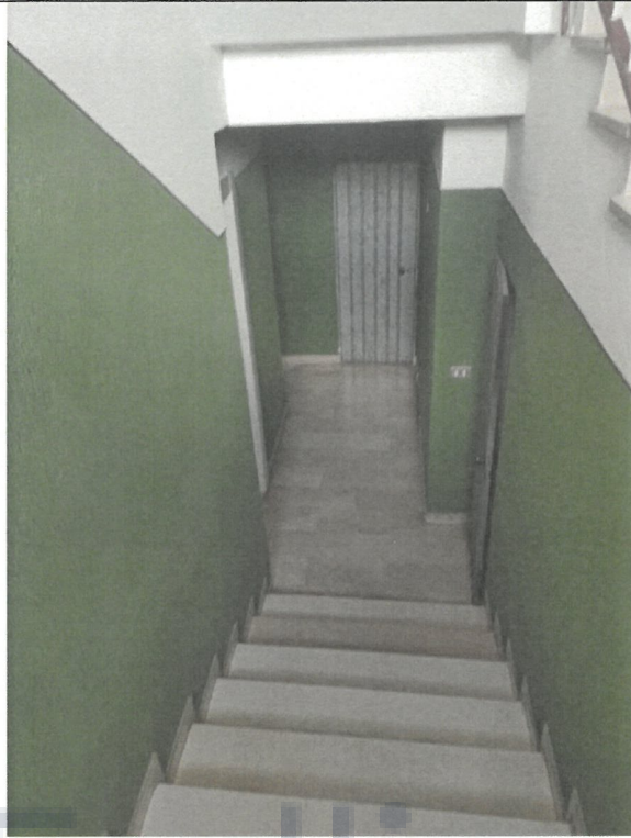
Scala condominiale accesso fondaco
