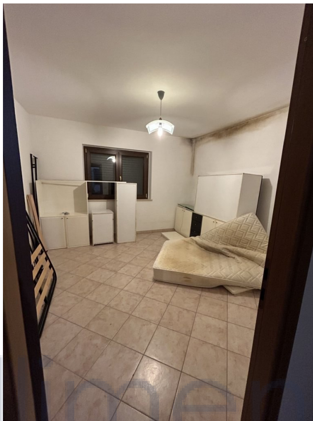
Foto 11 – Vista locali piano seminterrato
