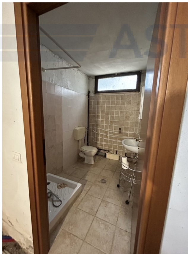
Foto 10 – Bagno piano seminterrato
