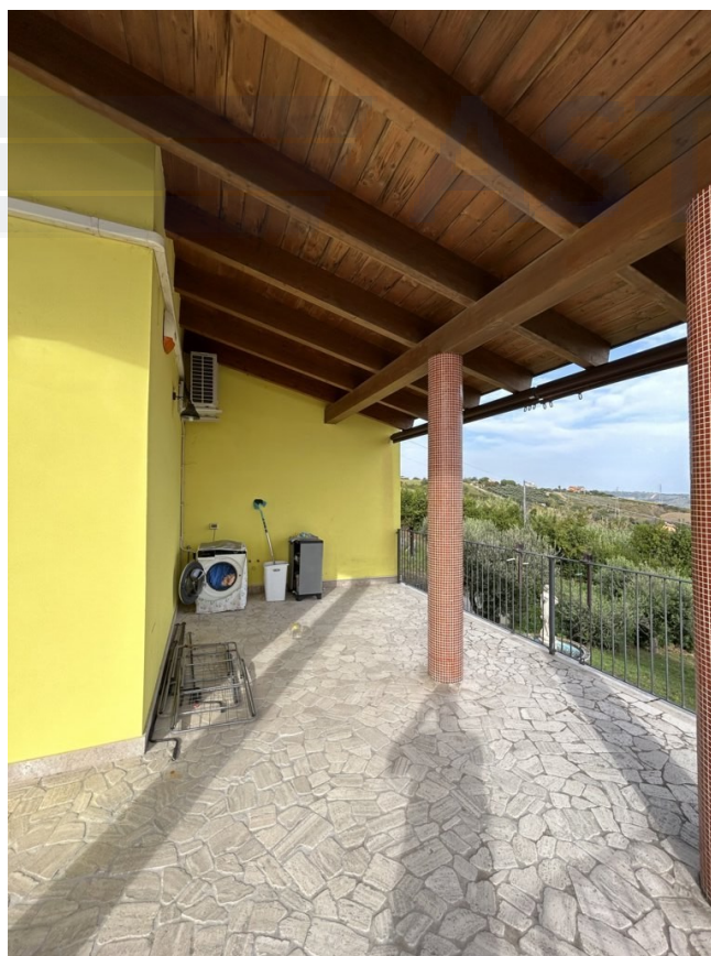
Foto 26 – Vista portico piano primo
