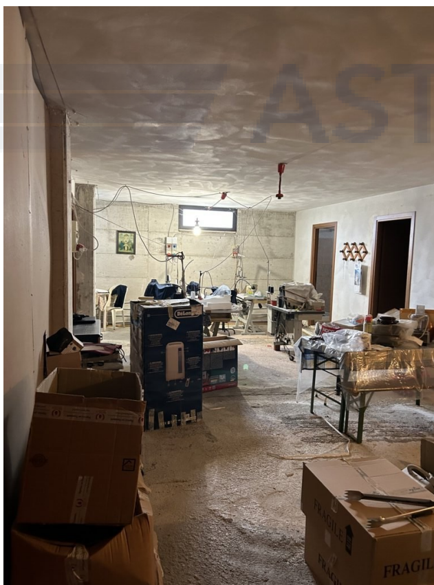
Foto 06 – Vista locali piano seminterrato
