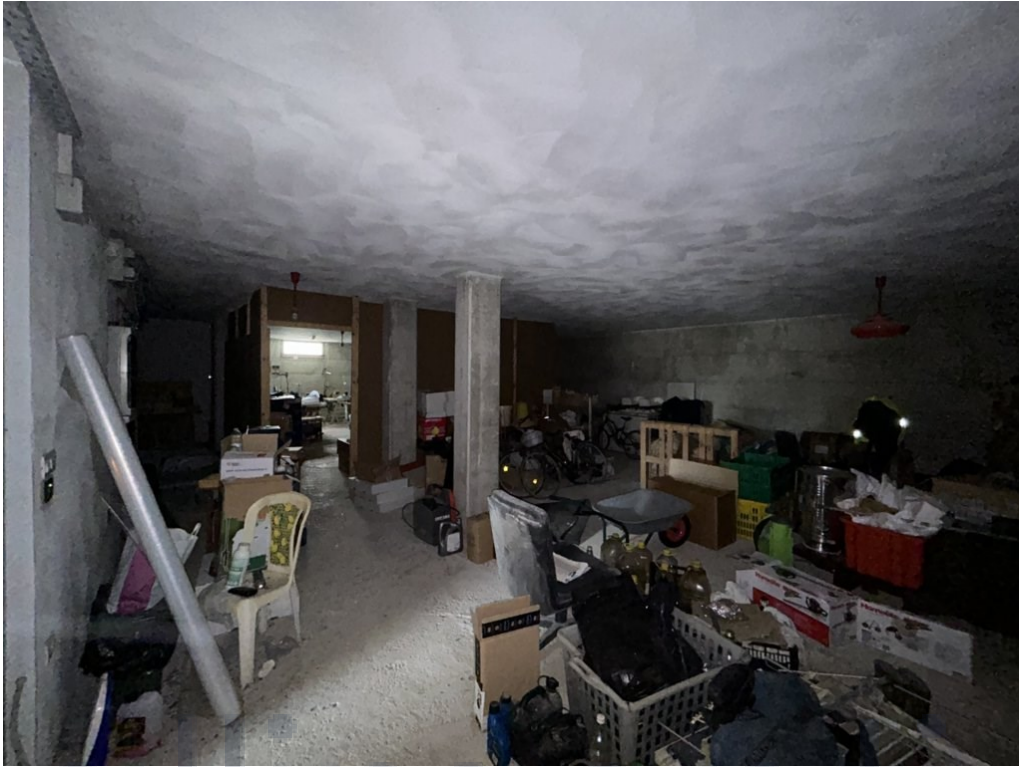
Foto 07 – Vista locali piano seminterrato
