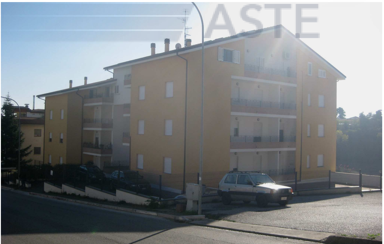
Foto n° 4: Vista dei fronti nord ed ovest del fabbricato su cui insistono gli immobili oggetto di stima
