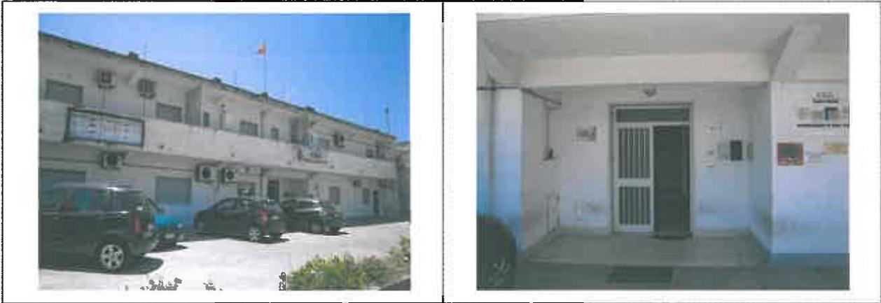
Le unità immobiliari nel loro complesso presentano un livello delle finiture e degli impianti sufficiente per le funzioni a cui sono destinate. In alcune unità sono presenti macchie di umidità e di condensa. Tutte le unità immobiliari, tranne il sub 10, si presentano in mediocre stato di manutenzione.
