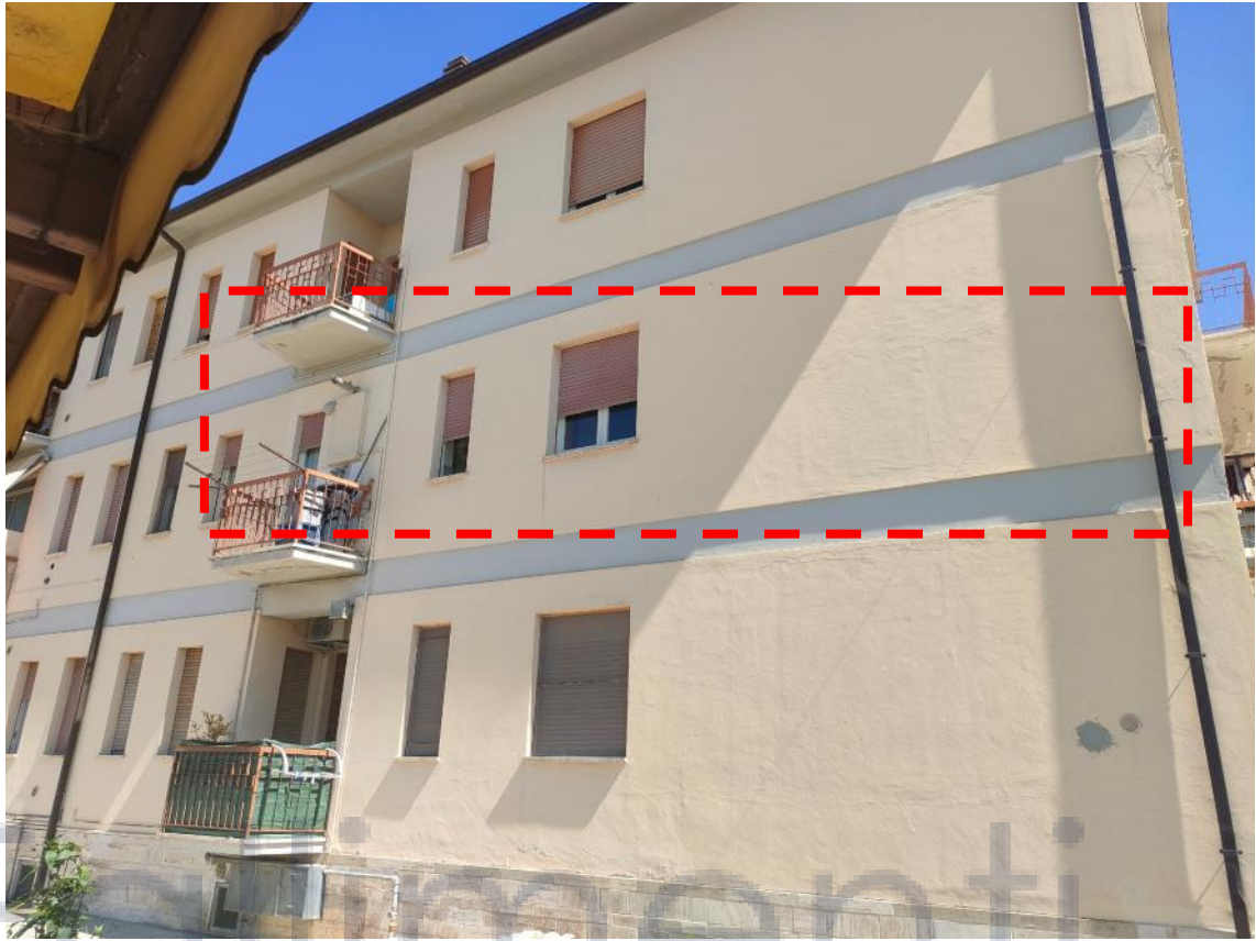
Vista retro palazzina - Abitazione al P. 1° con affaccio su area comune – corte fabbricato
