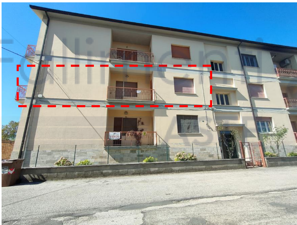
Vista fronte palazzina - Abitazione al P. 1° con affaccio su Via Garibaldi n. 3
