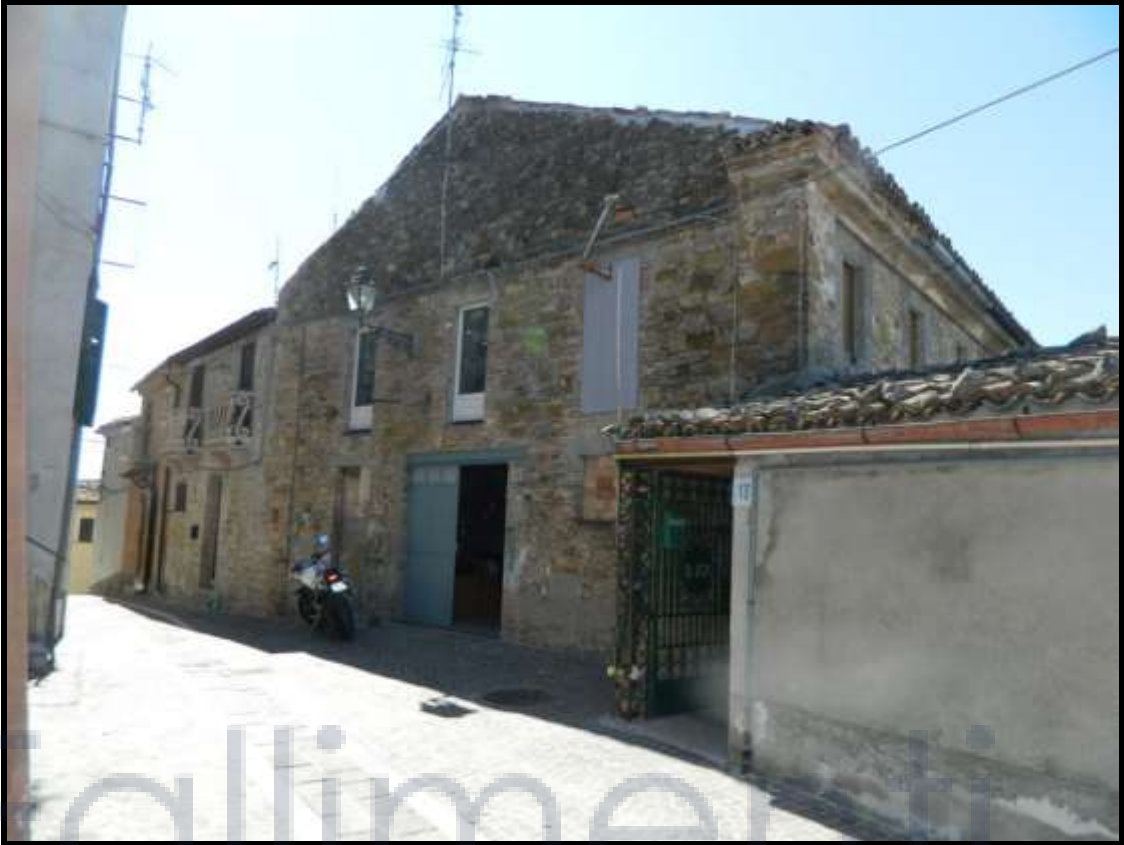
Foto 01 – Vista esterna immobile
