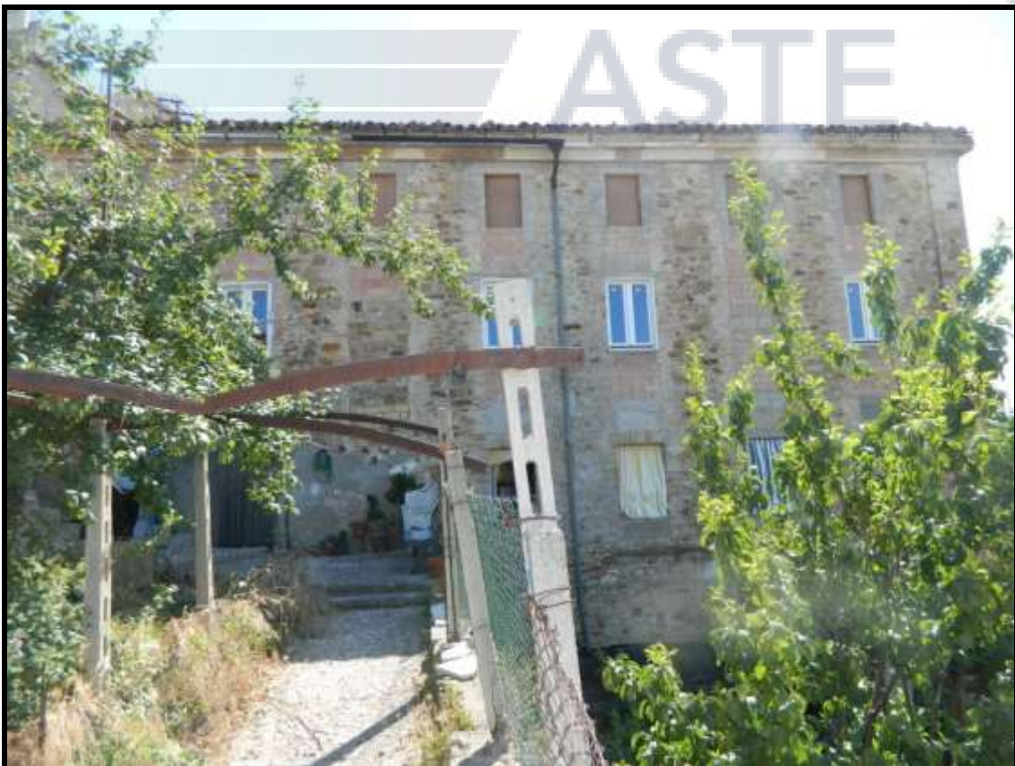
Foto 02 – Vista esterna immobile
