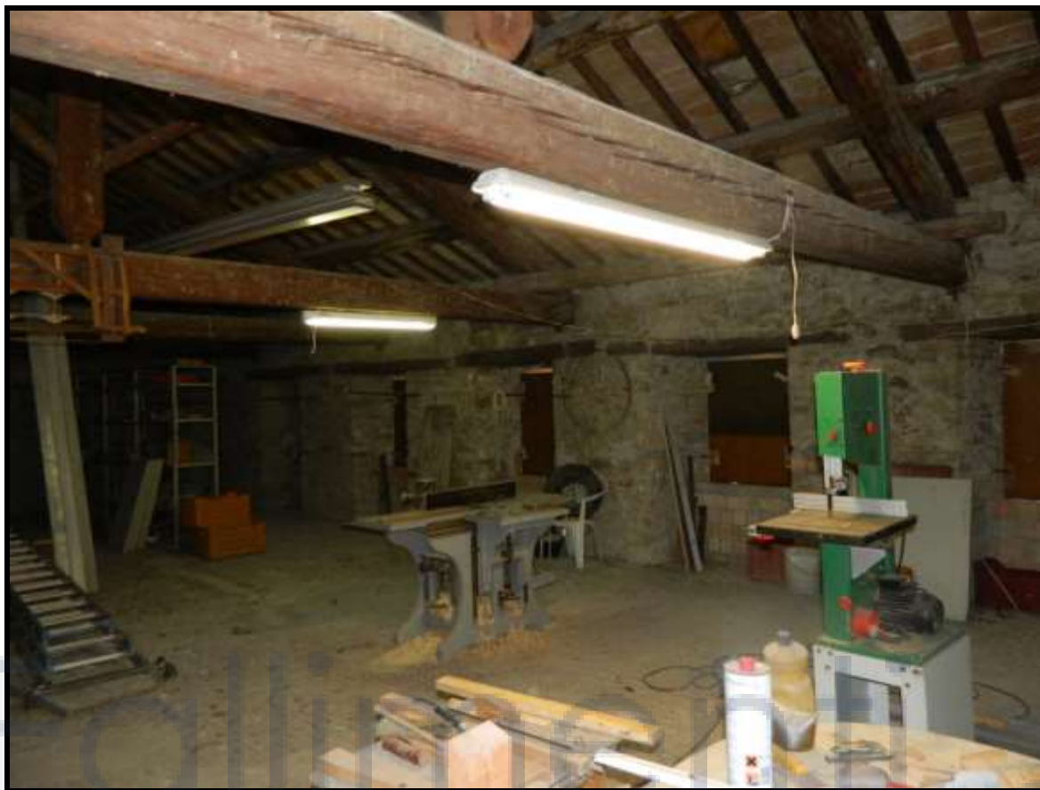
Foto 13 – Vista magazzino Piano Primo (Sottotetto)
