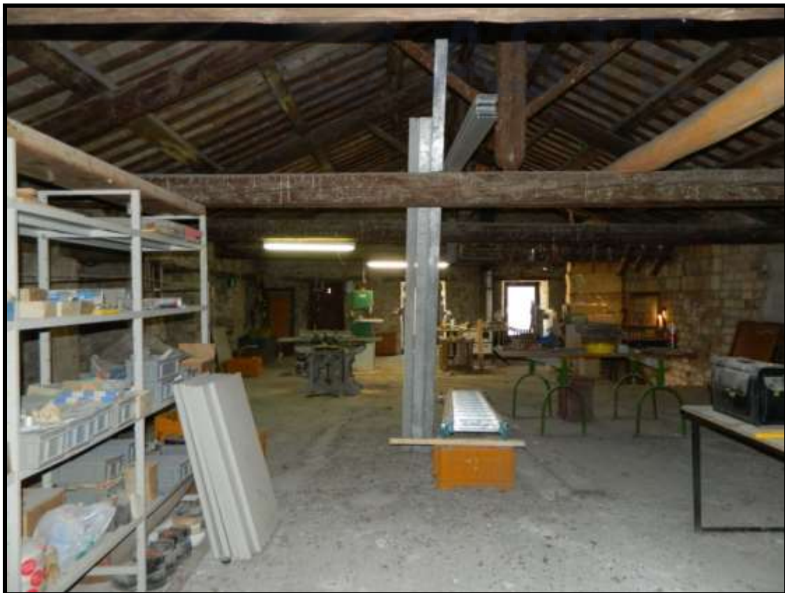
Foto 12 – Vista magazzino Piano Primo (Sottotetto)
