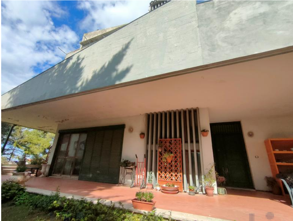
FOTO ACCESSO VILLA P.T.
