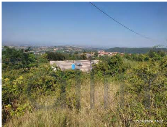
39 (copertura edificio vista dalla collina adiacente)
