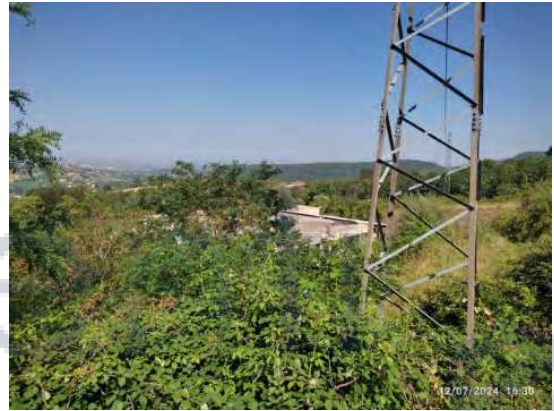
40 (copertura edificio vista dalla collina adiacente)
