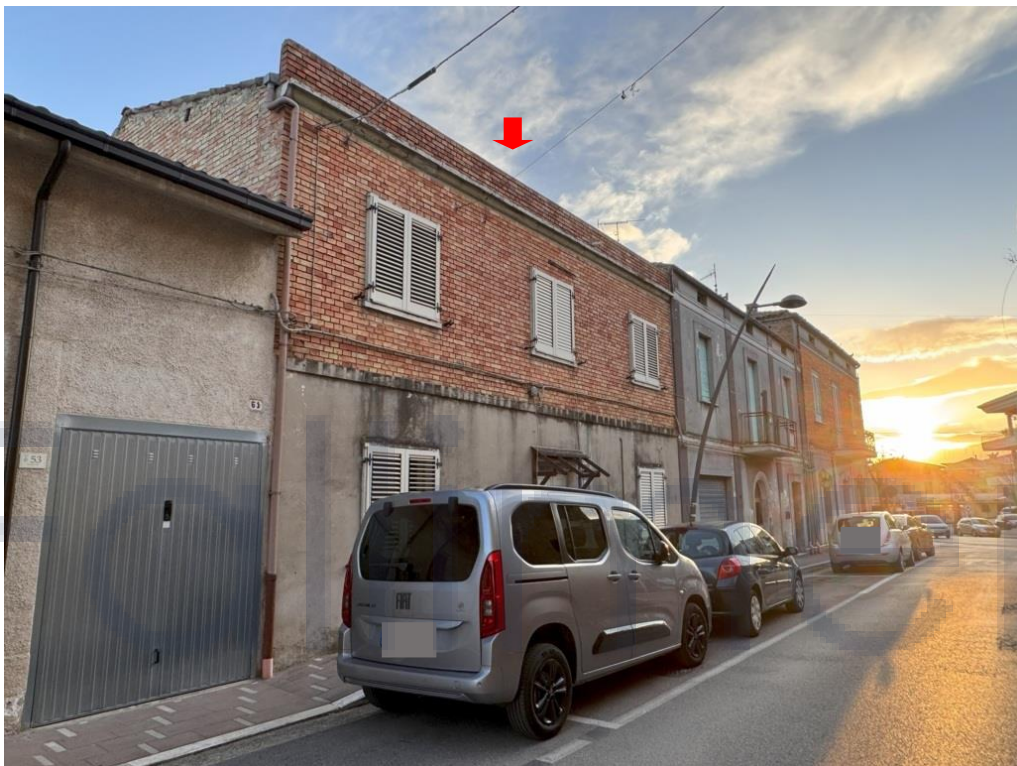
3. Vista fronte principale del fabbricato, su Via Dino Lelli
