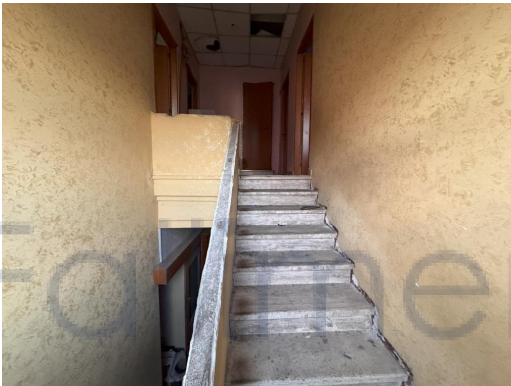
15. Vista della rampa di accesso della scala al piano primo
