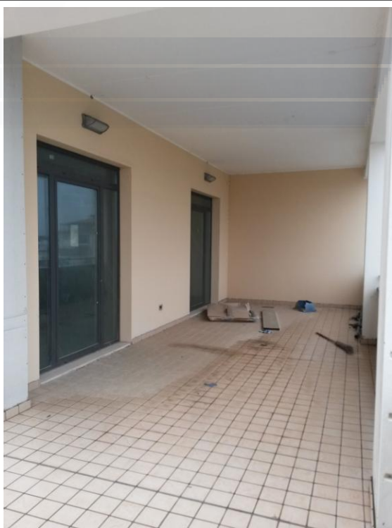
Vista ESTERNA LOGGIA sub 54
