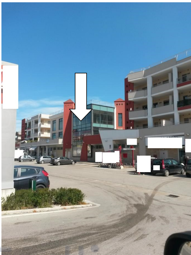
Vista esterna lato nord - ovest
