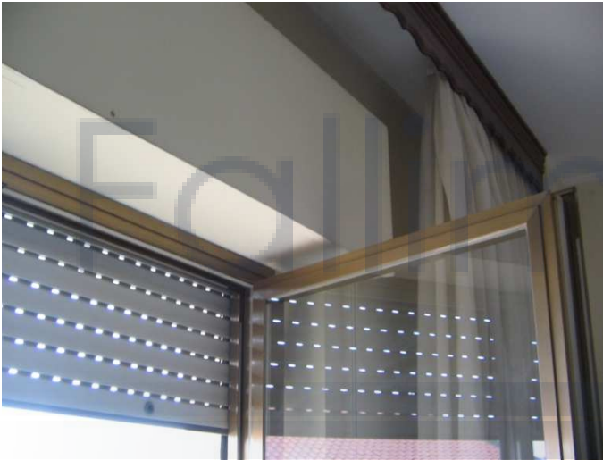
Particolare infissi con cassonetti
