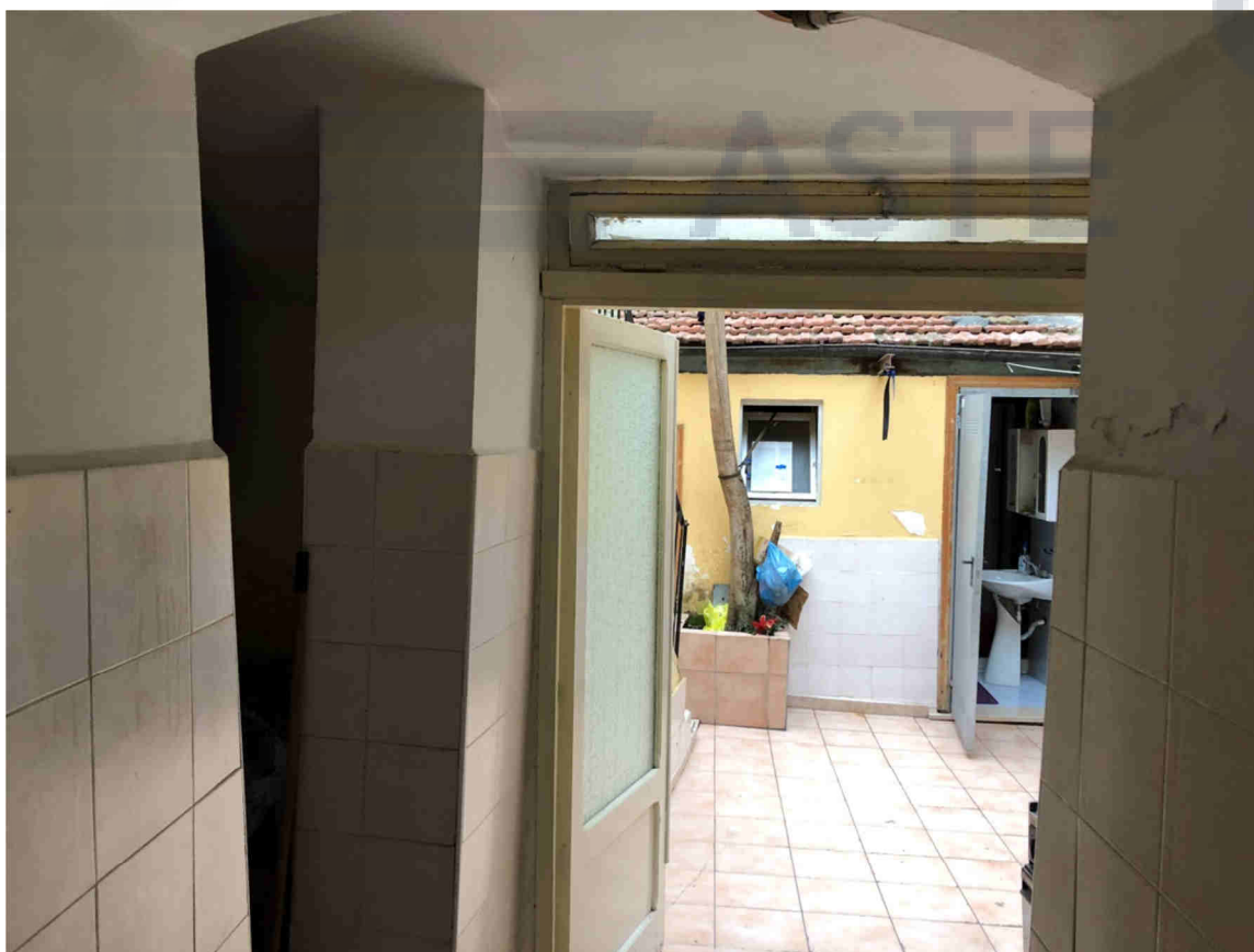
Foto n.6 – Piano terra (Ripostiglio – uscita su cortile interno)
