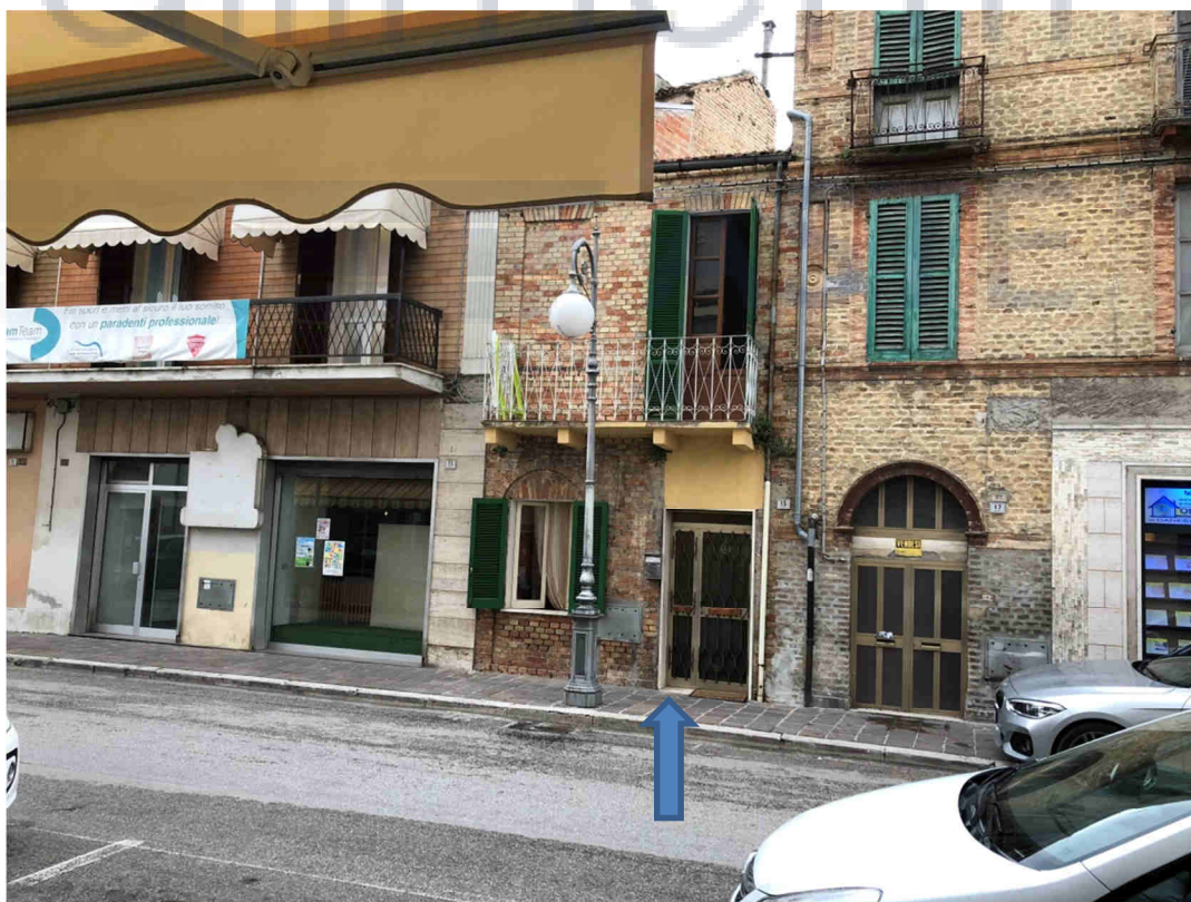
Foto n.2 – Vista da Viale Roma
