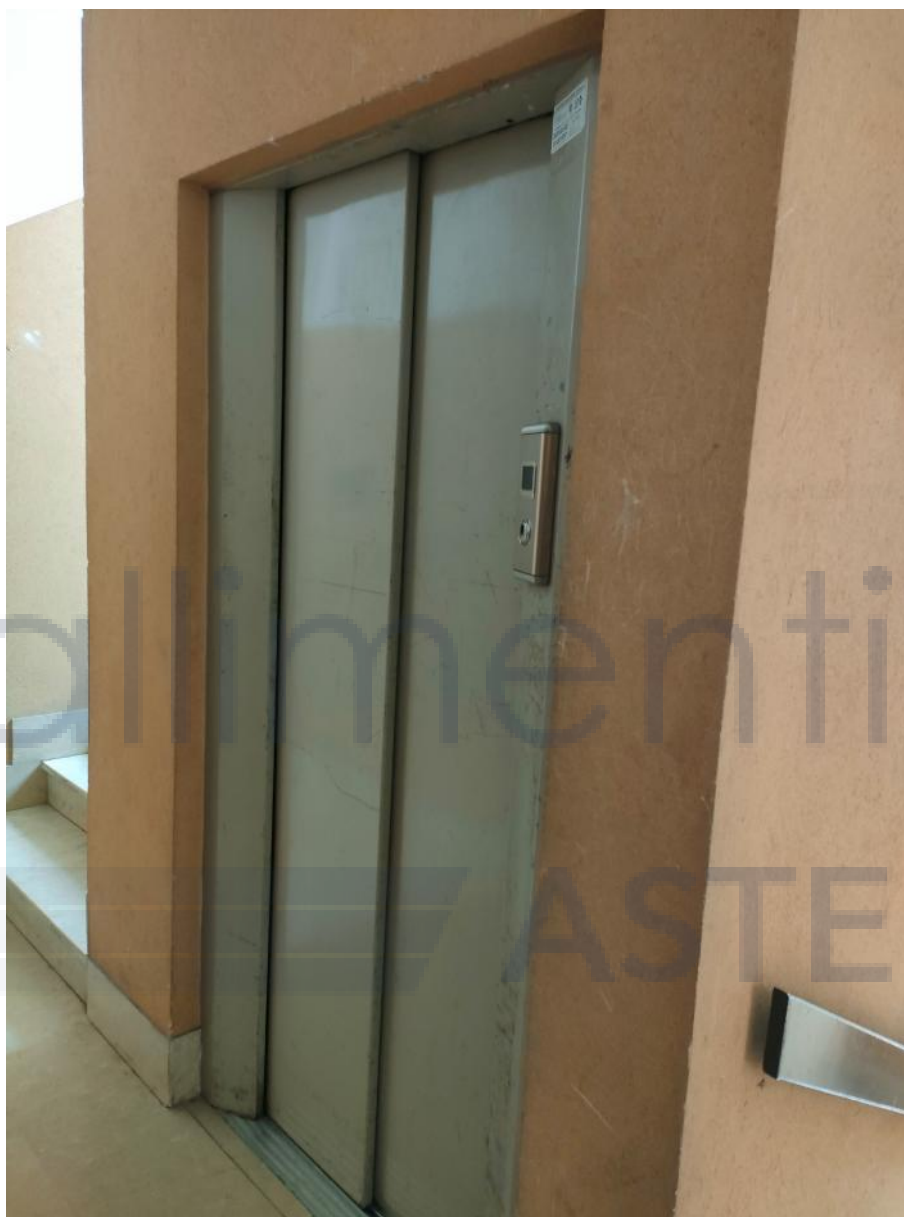
Vano scala ed Ascensore condominiale
