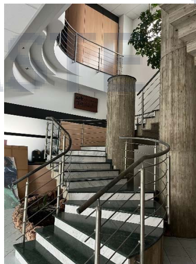
FOTO 36 Vista ingresso rampe scale
