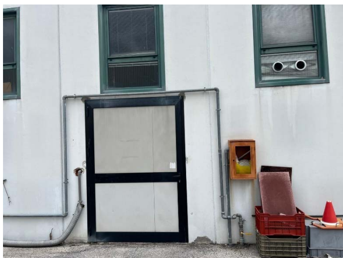
FOTO 13 Vista porta sicurezza su lato Ovest
