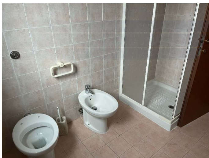
FOTO 119 Vista abitazione P.1°
