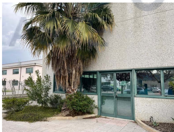
FOTO 16 Vista ingresso spaccio aziendale su angolo Sud/Ovest
