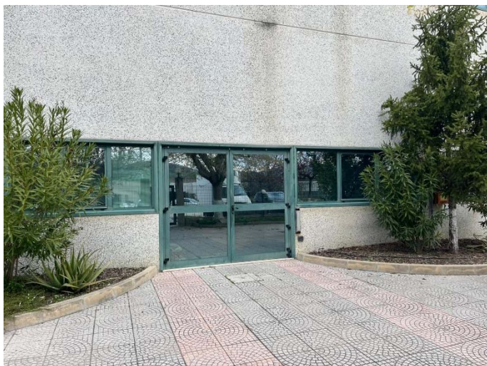
FOTO 17 Vista ingresso principale lato Sud
