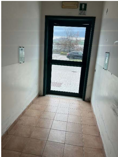
FOTO 83 Vista interno ingresso dipendenti
