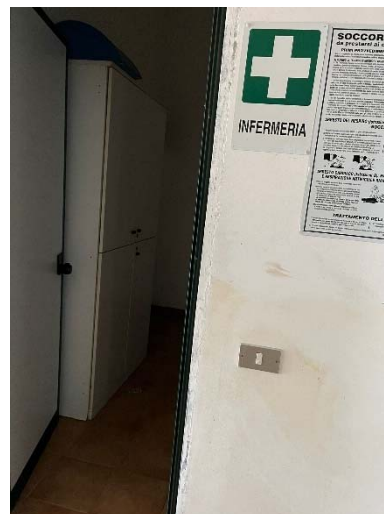
FOTO 86 Vista interno ingresso locale infermeria
