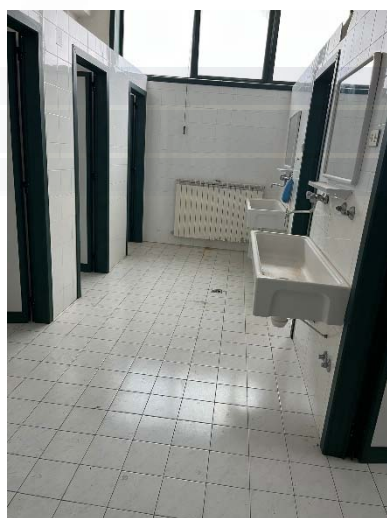
FOTO 95 Vista interno spogliatoio donne
