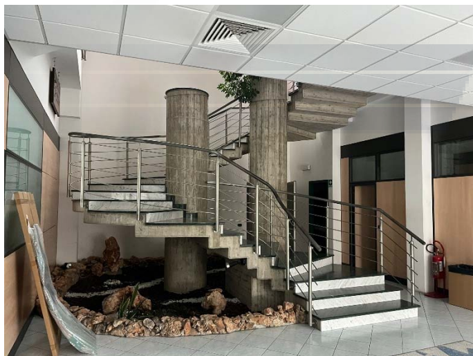
FOTO 35 Vista ingresso rampe scale
