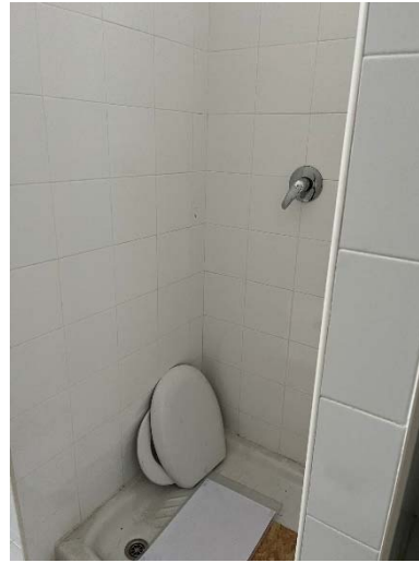
FOTO 102 Vista interno spogliatoio donne
