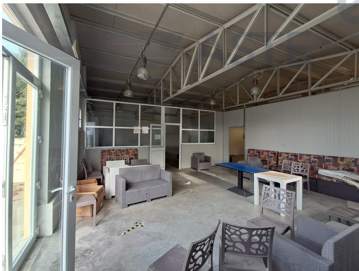
Foto 6: PART.LLA 292 LOCALLI INGRESSO.
