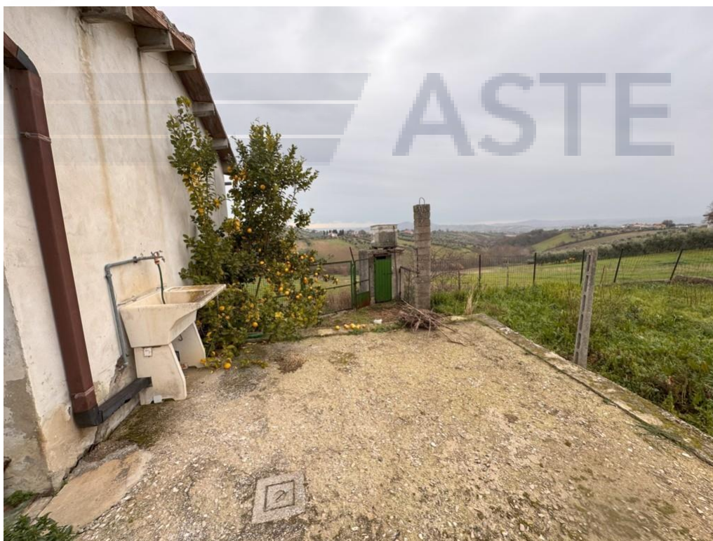
49. Vista del vecchio w.c. esterno
