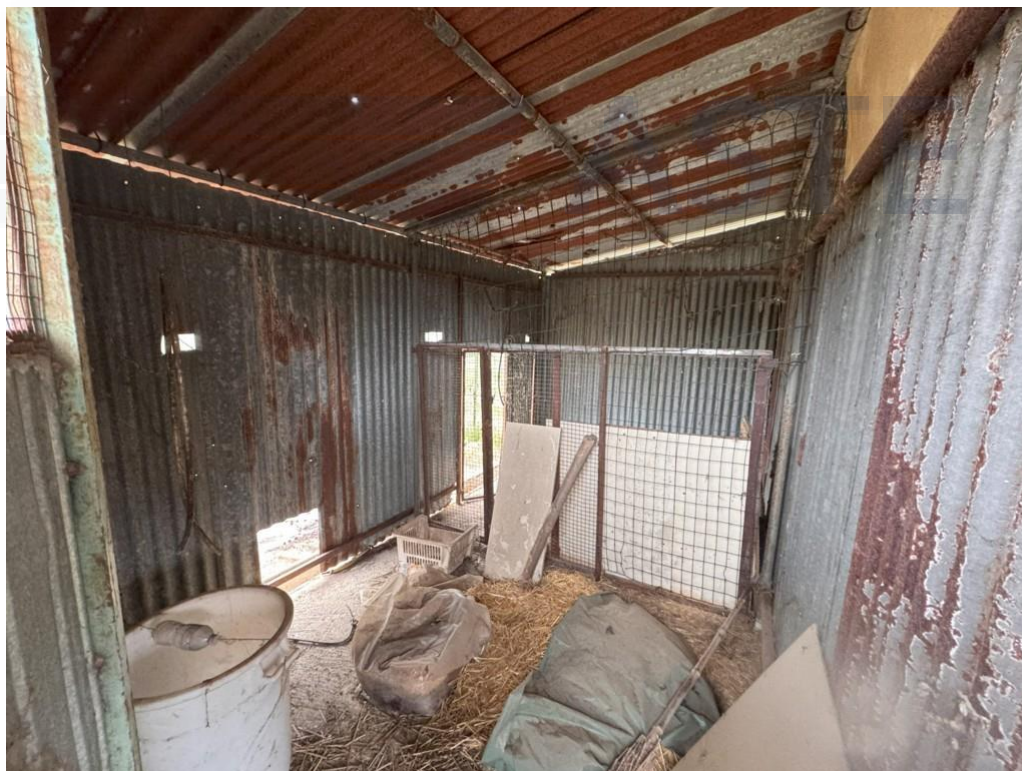
43. Vista di parte della rimessa
