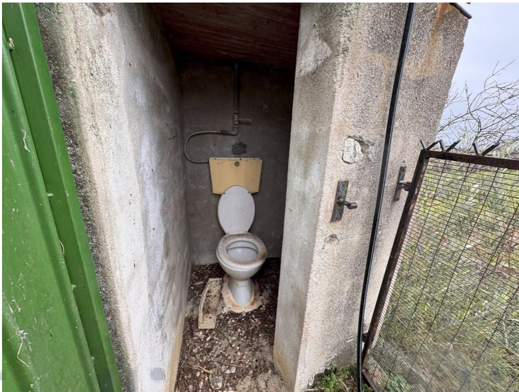
50. Vista del vecchio w.c. esterno
