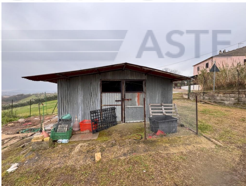
41. Vista del manufatto ad uso rimessa
