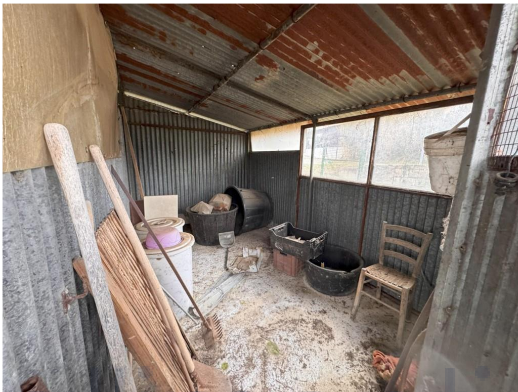
42. Vista di parte della rimessa
