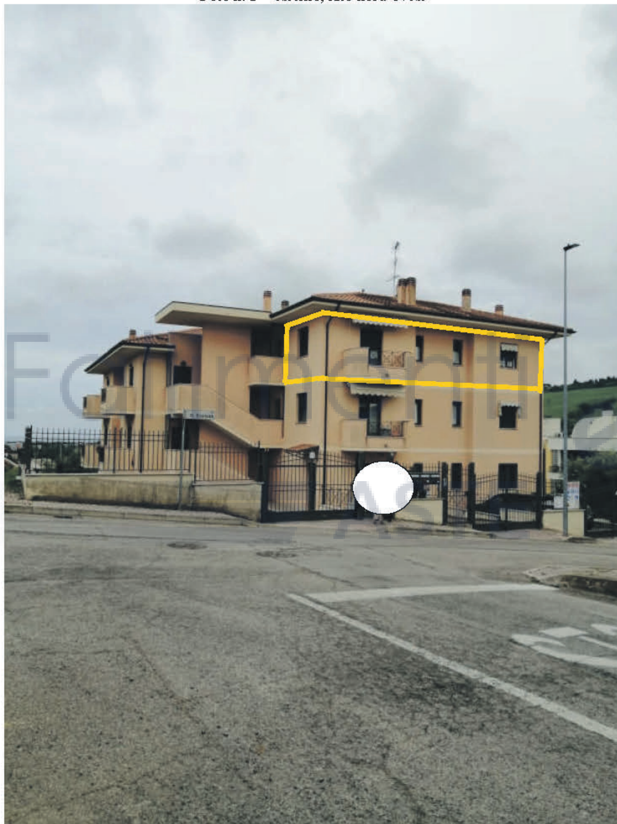
Foto n. 1 – esterno, lato nord-ovest
