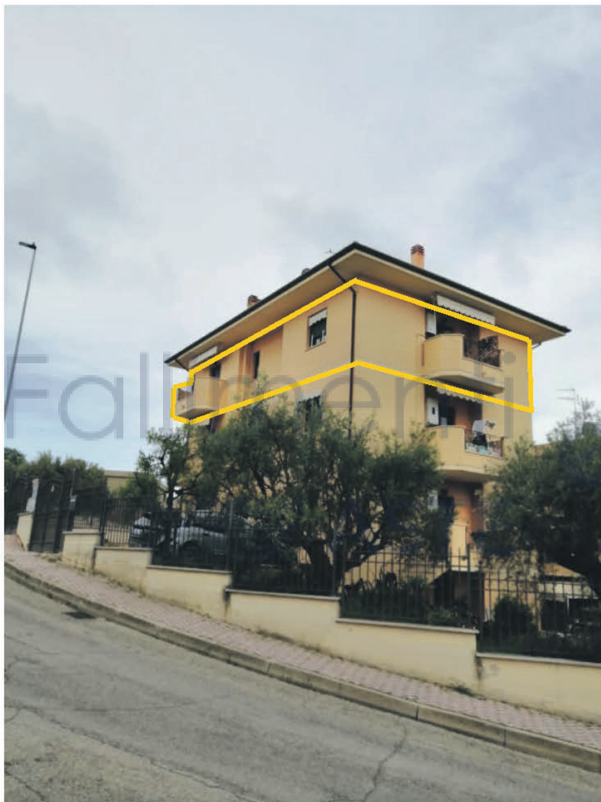
Foto n. 2 – esterno, lati nord-ovest e sud-ovest
