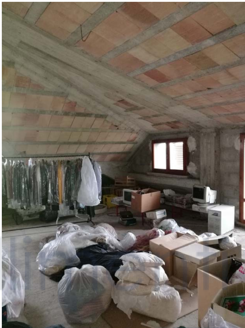
- Soffitta piano sottotetto
