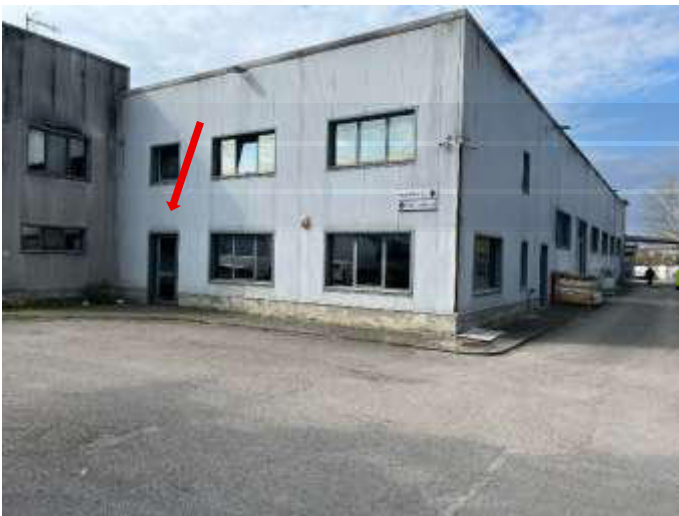
FOTO 3 Vista ingresso uffici
