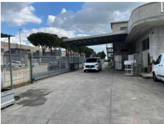
FOTO 7 Vista tettoia lato Nord
