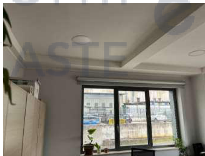
FOTO 24 Vista interno ingresso Uffici P.T.
