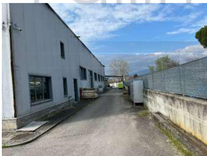
FOTO 11 Vista lato Nord dall'interno cancello carrabile e
