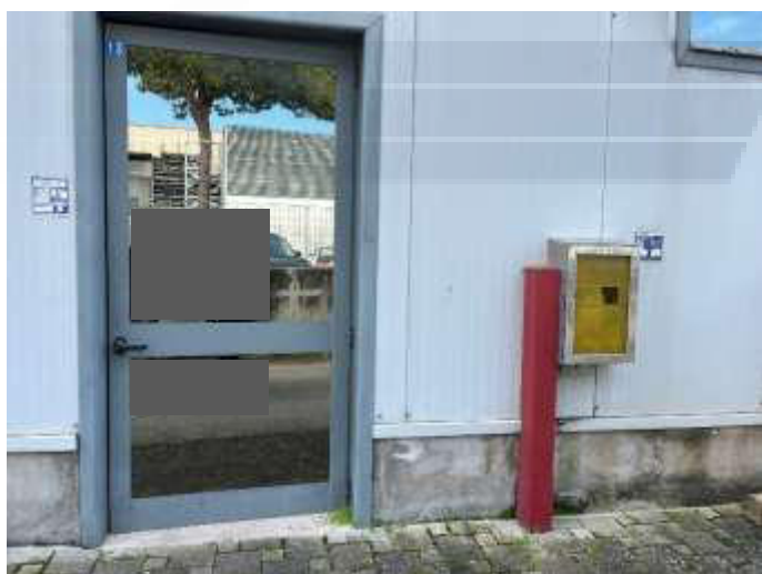
FOTO 59 Vista accesso secondario sul lato Nord e bocchette VV. F
