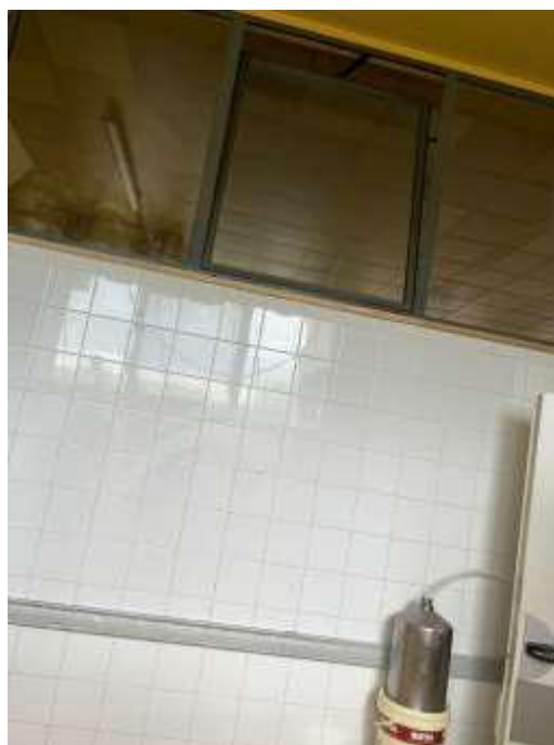
FOTO 50 Vista interno opificio
