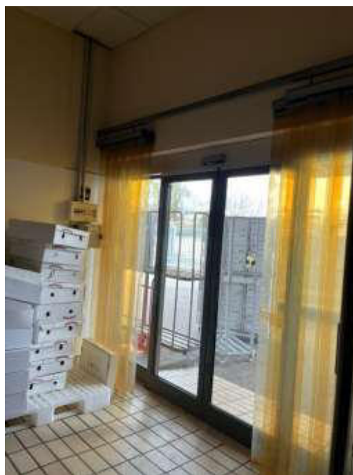
FOTO 42 Vista interno opificio
