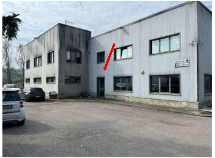
FOTO 2 Vista ingresso uffici
