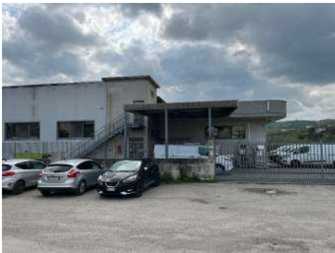
FOTO 5 Vista da Via Giovanni Fuschi Ingresso carrabile, automezzi e tettoia Protezione carico e scarico
