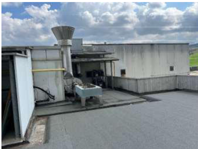
FOTO 55 Vista lastrico solare e tettoia protezione macchinari
