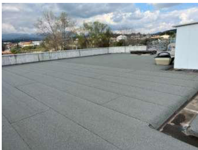
FOTO 57 Vista lastrico solare
