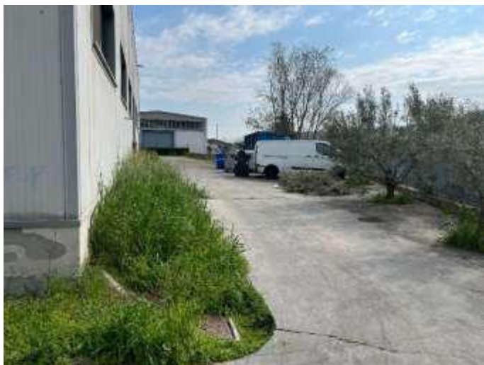
FOTO 69 Vista criticità lato sud
