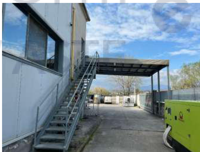
FOTO 12 Vista tettonica Nord e scala di accesso al deposito e lastrico solare Piano 1°
