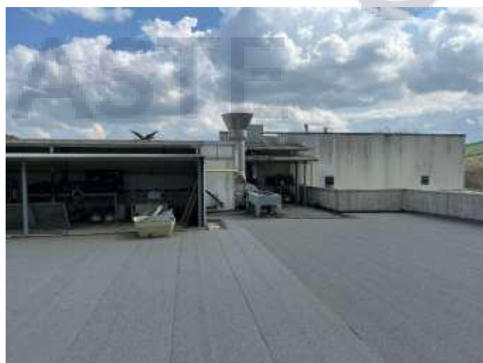
FOTO 56 Vista lastrico solare e tettoia protezione macchinari
