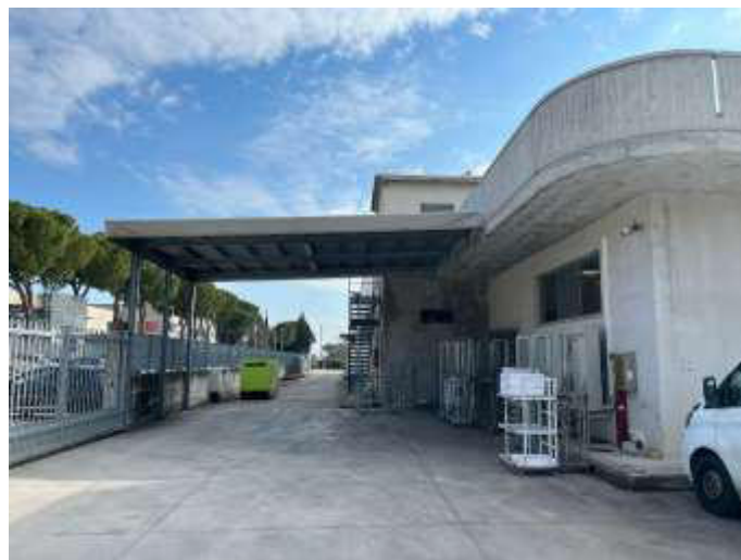
FOTO 6 Vista tettoia lato Nord
