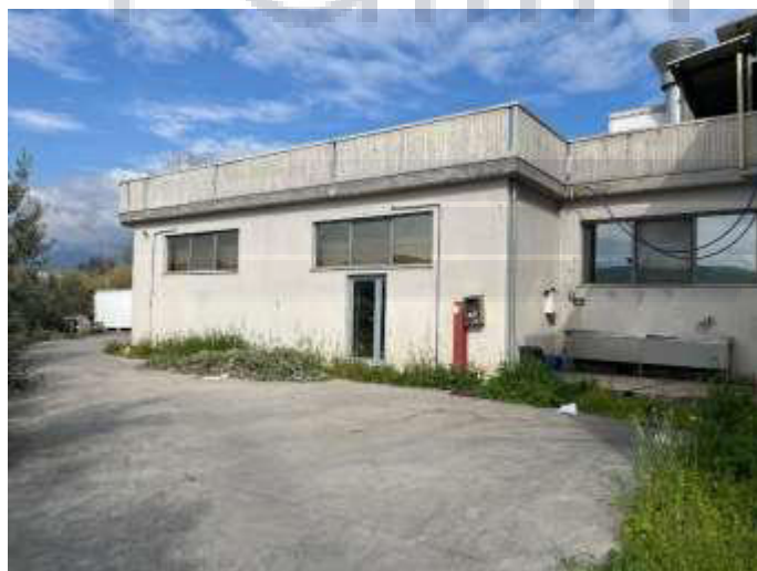
FOTO 19 Vista lato Sud
