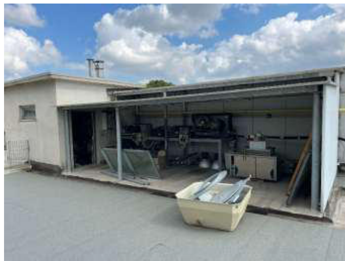
FOTO 58 Vista tettoia protezione macchinari P.1°
