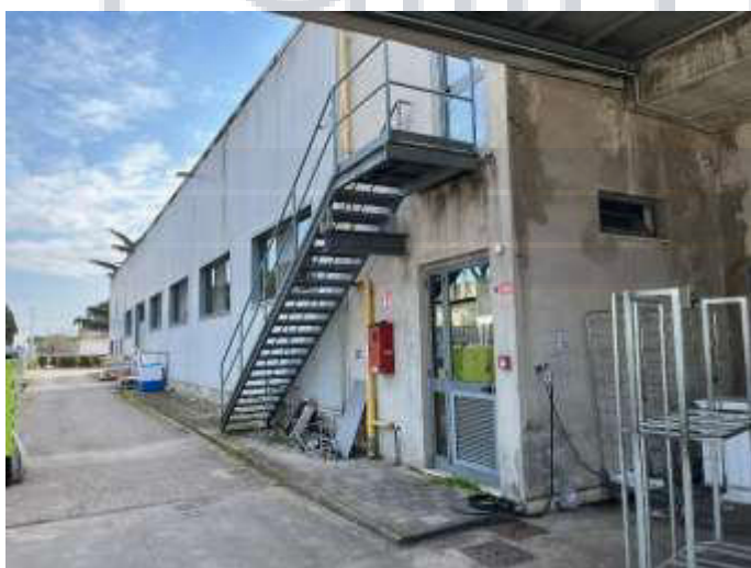
FOTO 15 Vista opificio lato Nord e scala di accesso deposito e lastrico solari Piano 1°
