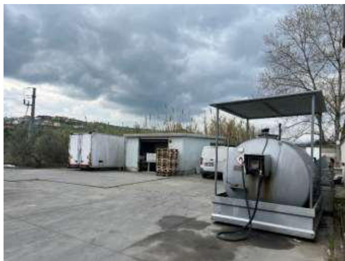
FOTO 62 Vista locale compressore/ripostiglio
