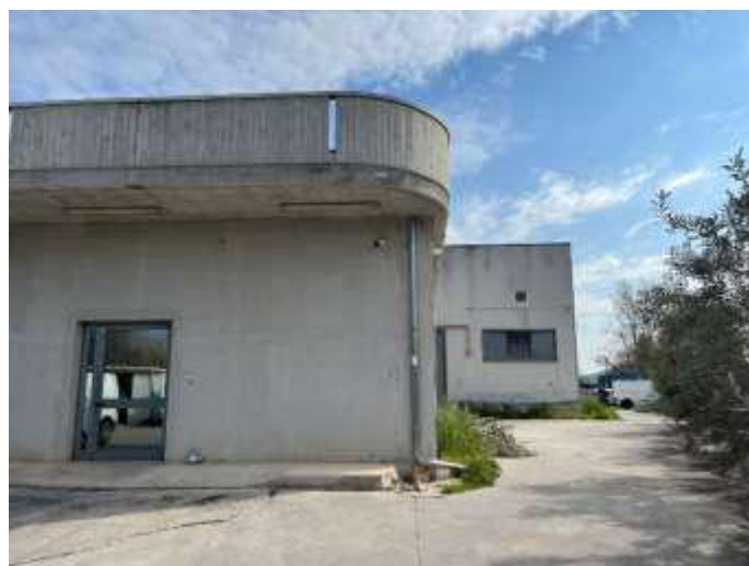
FOTO 18 Vista lato Ovest/Sud
