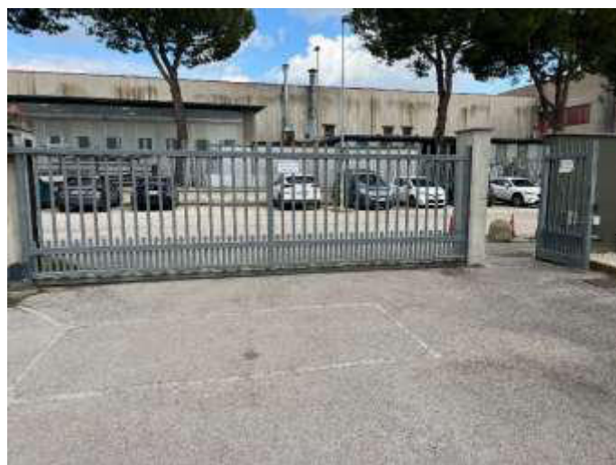
FOTO 10 Vista dall'interno cancello carrabile e pedonale principale
