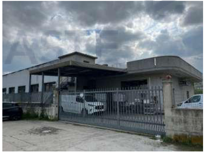
FOTO 4 Vista da Via Giovanni Fuschi Ingresso carrabile, automezzi e tettoia protezione carico e scarico
