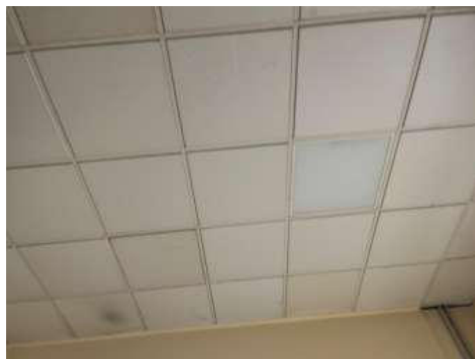
FOTO 46 Vista controsoffitto interno opificio
