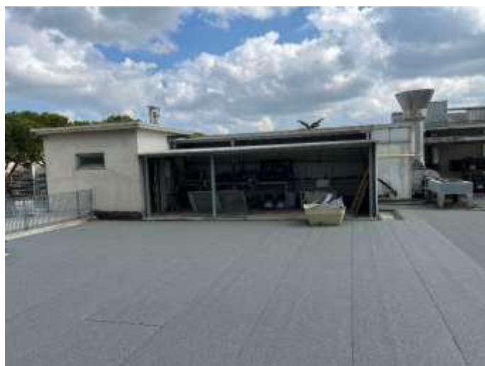
FOTO 54 Vista lastrico solare e tettoia protezione macchinari
