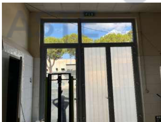
FOTO 44 Vista interno opificio
