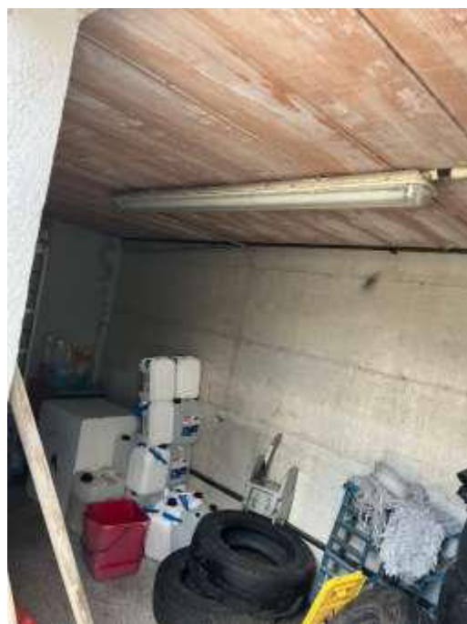
FOTO 66 Vista locale pulizia automezzi
