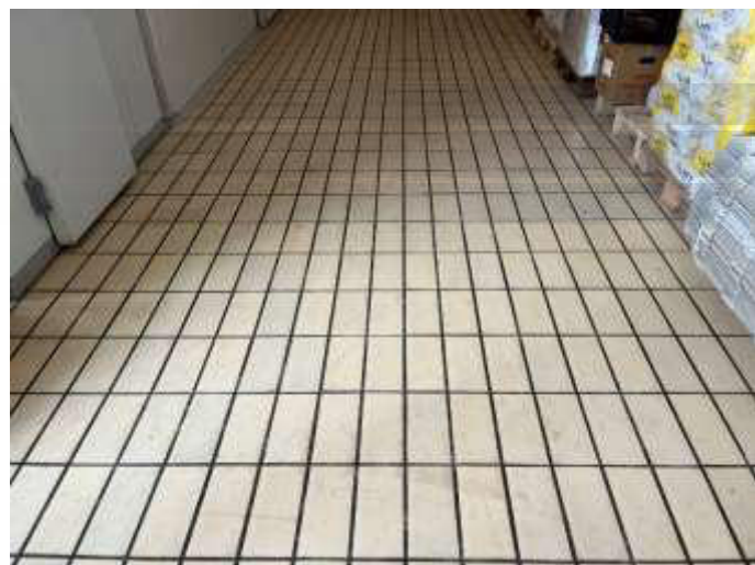
FOTO 39 Vista pavimentazione interna opificio
