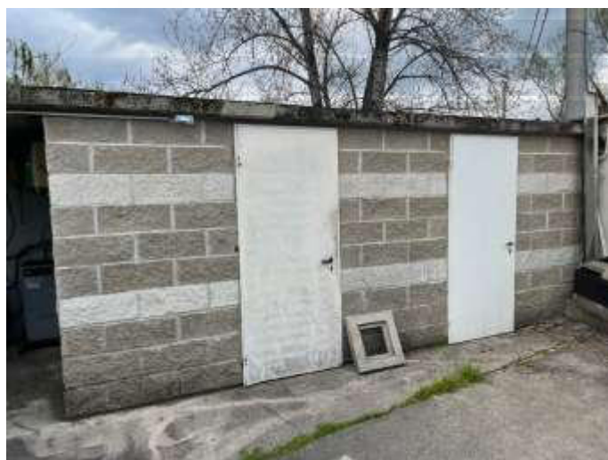
FOTO 67 Vista locale pulizia automezzi
