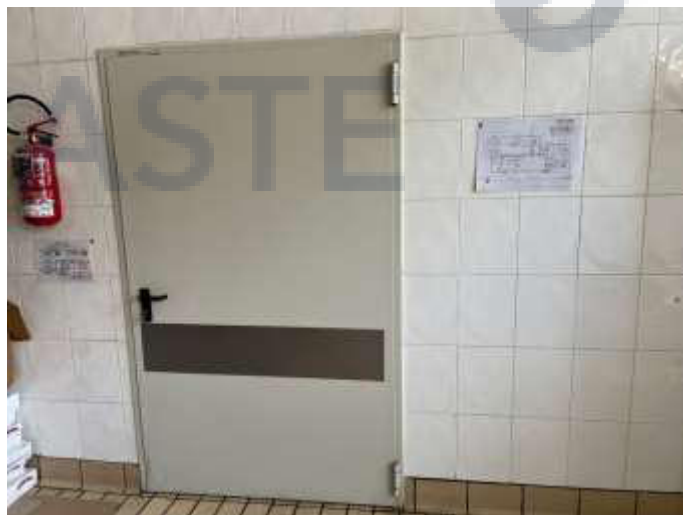
FOTO 40 Vista interno opificio
