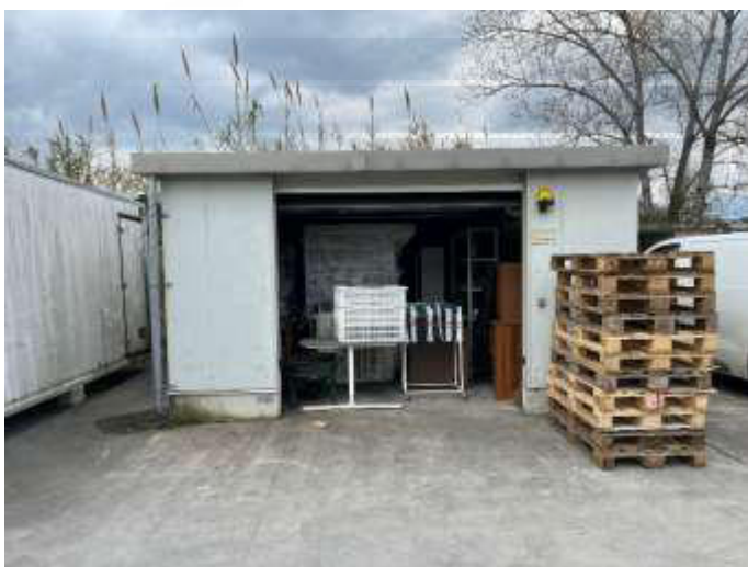
FOTO 63 Vista locale ripostiglio
