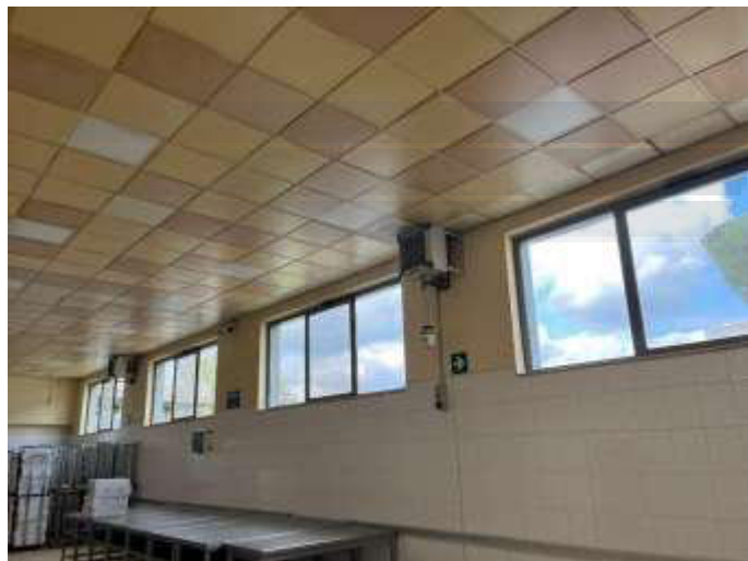
FOTO 35 Vista interno opificio
