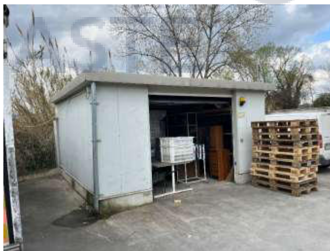
FOTO 64 Vista locale ripostiglio
