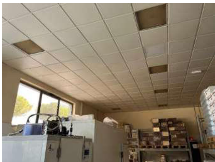
FOTO 45 Vista interno opificio
