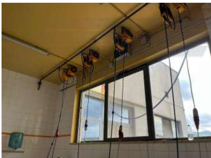
FOTO 51 Vista interno opificio
