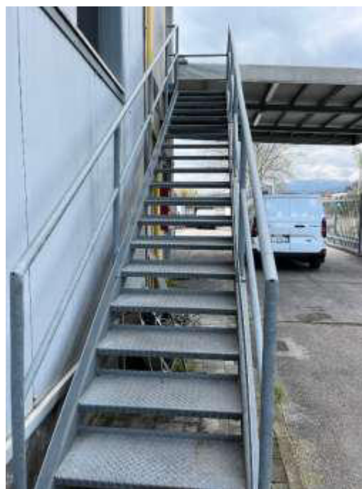
FOTO 14 Vista scala di accesso deposito e lastrico solare Piano 1°
