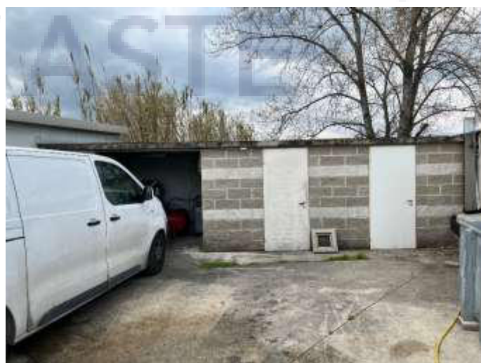
FOTO 68 Vista locale pulizia automezzi
