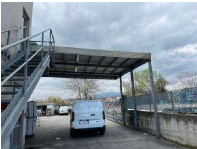
FOTO 13 Vista tettoia Nord
