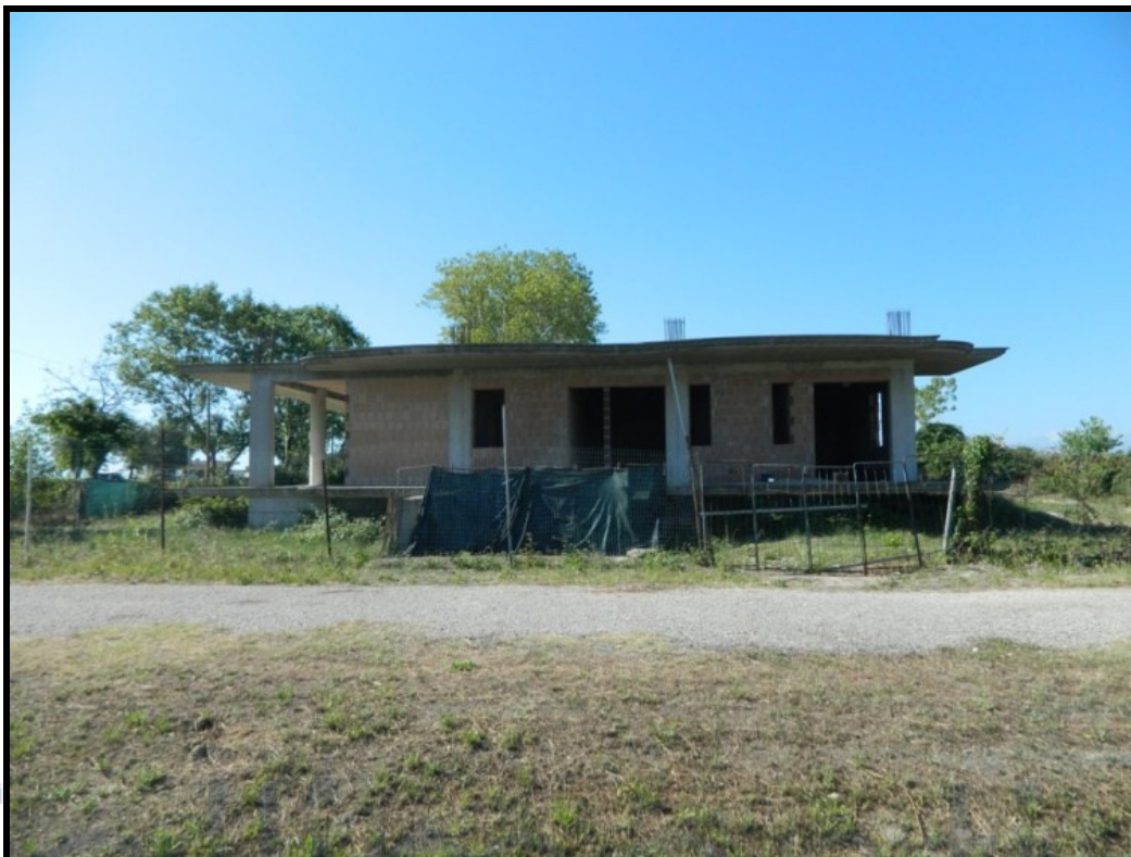
03 – Vista immobile lato Nord
