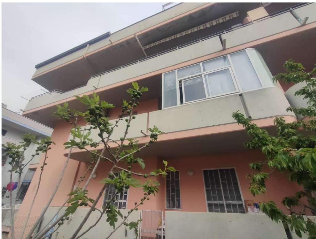
Vista posteriore fronte sud
