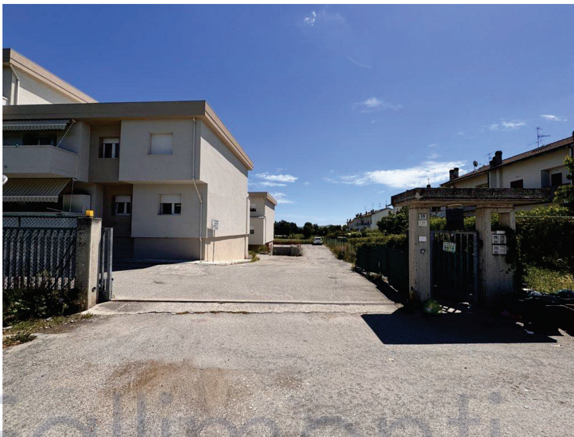
1. Vista dell'accesso al complesso residenziale da Via XXV Aprile
