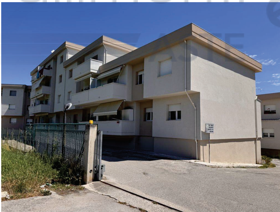
2. Vista angolo sud-ovest del fabbricato
