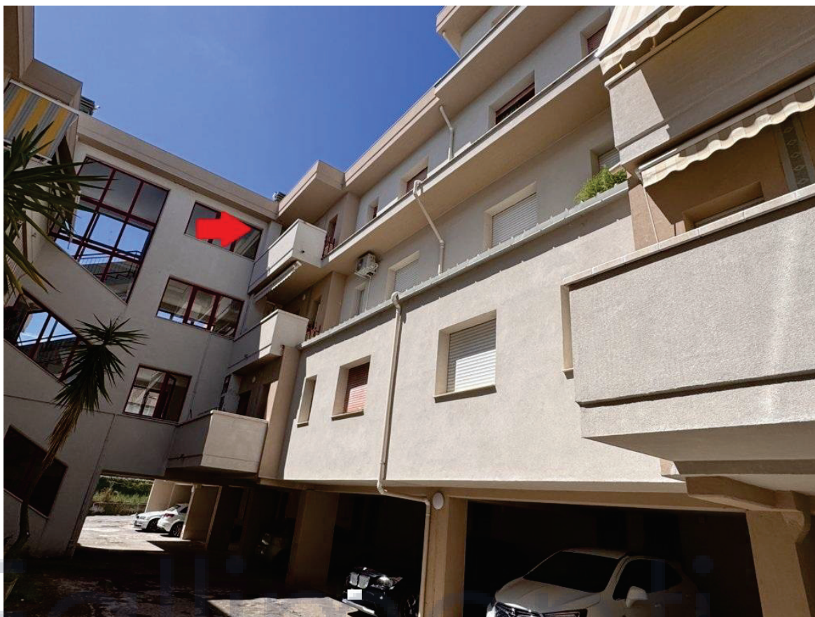
5. Vista lato est del fabbricato dall'area di corte condominiale
