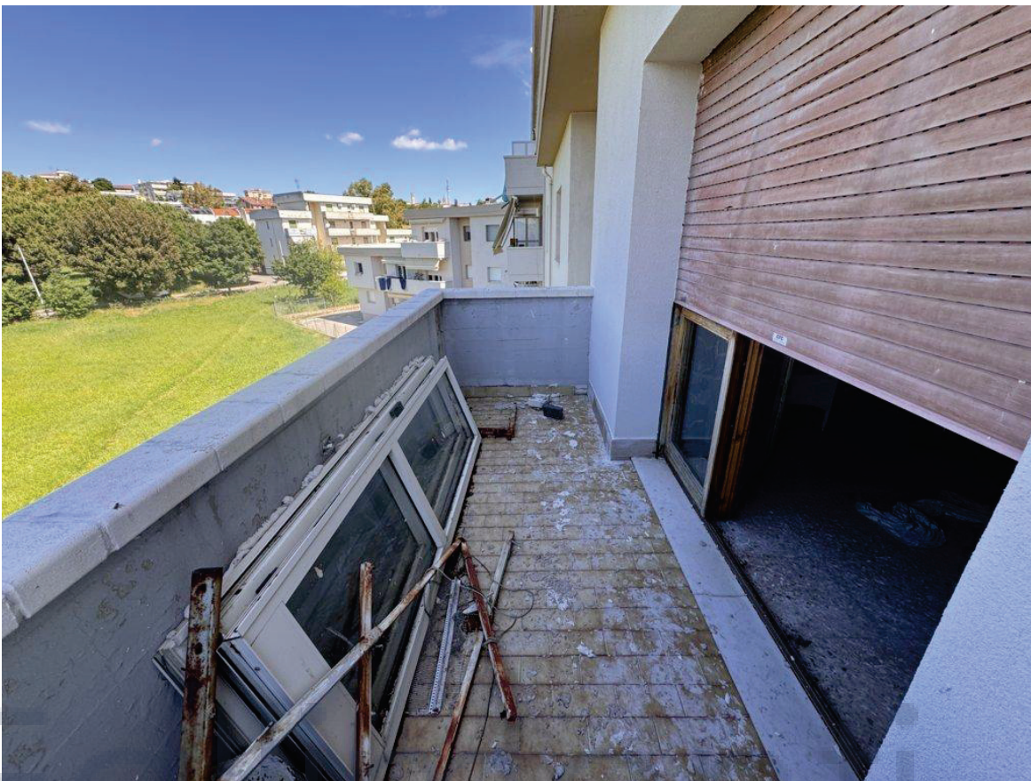
11. Vista del balcone sul lato ovest
