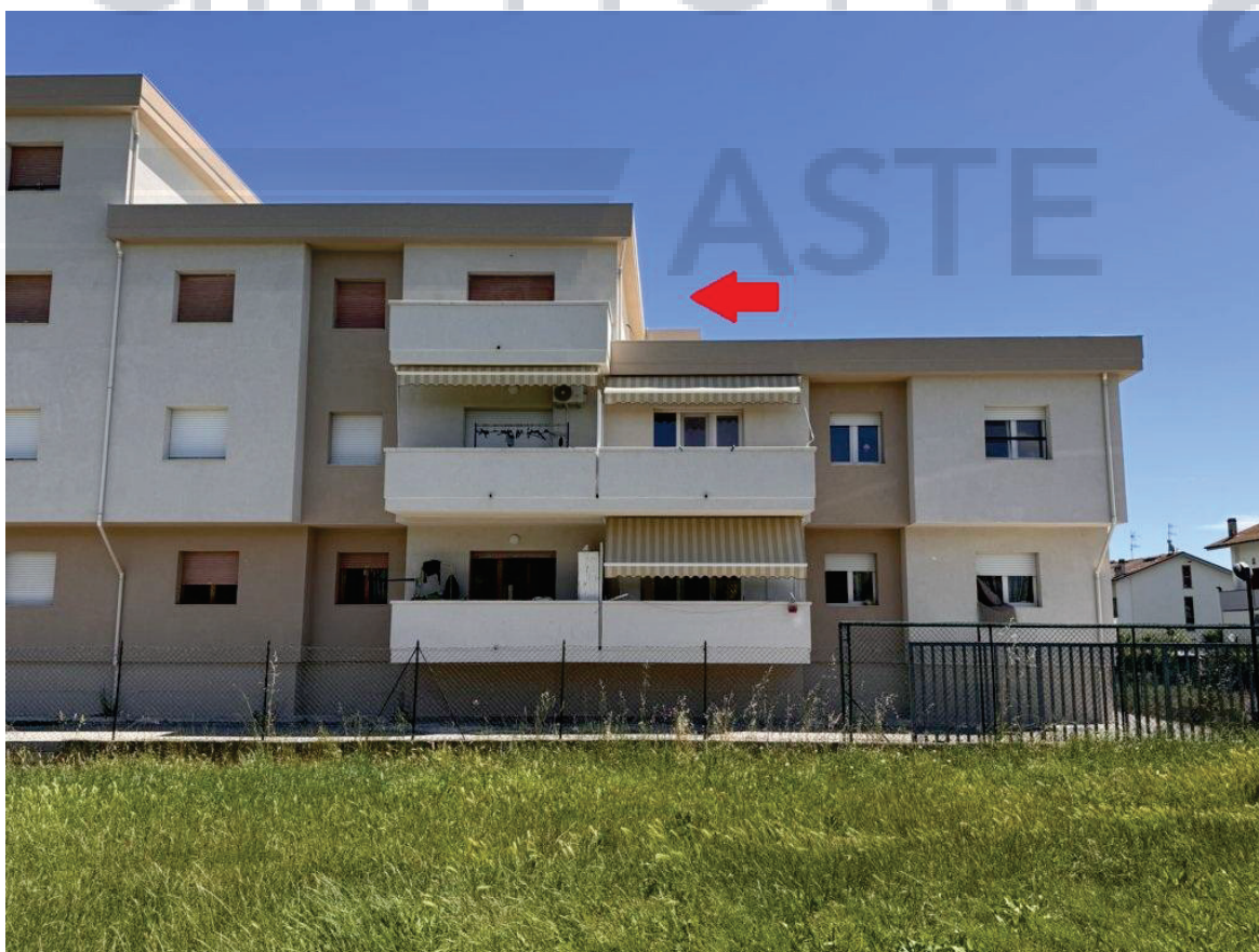
4. Vista lato ovest del fabbricato
