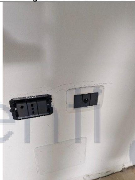
Foto 34 – Dettaglio placca elettrica mancante locale sottotetto
