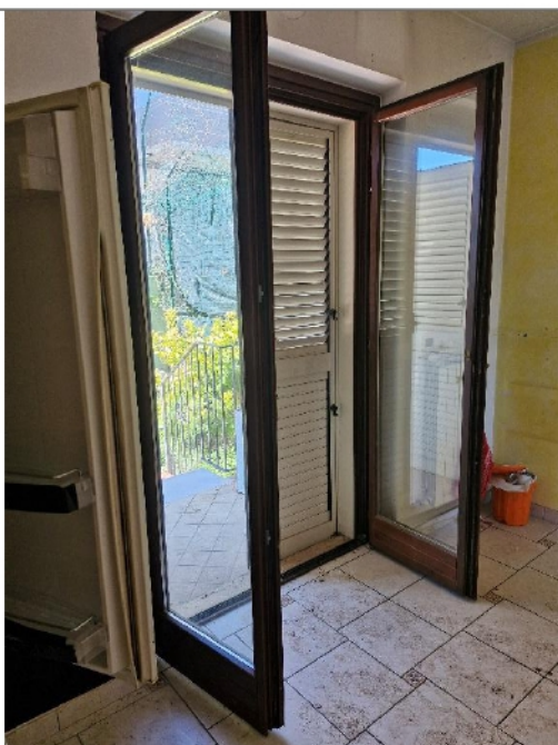
Foto 41 – Dettaglio tipologia infisso in legno con doppio vetro
