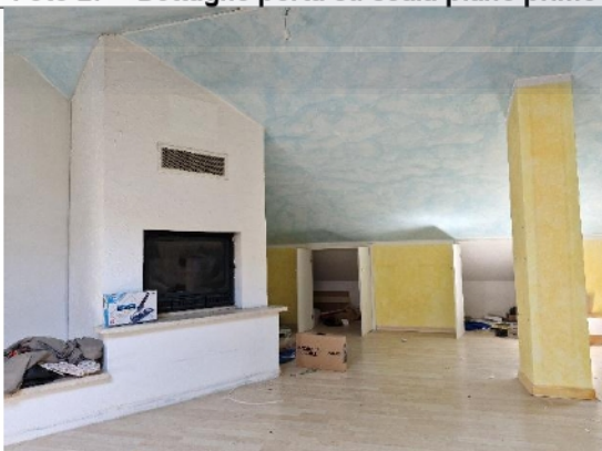
Foto 29 – Vista locale sottotetto con camino e panche in muratura
