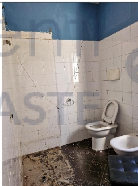
Foto 17 – Bagno piano rialzato
