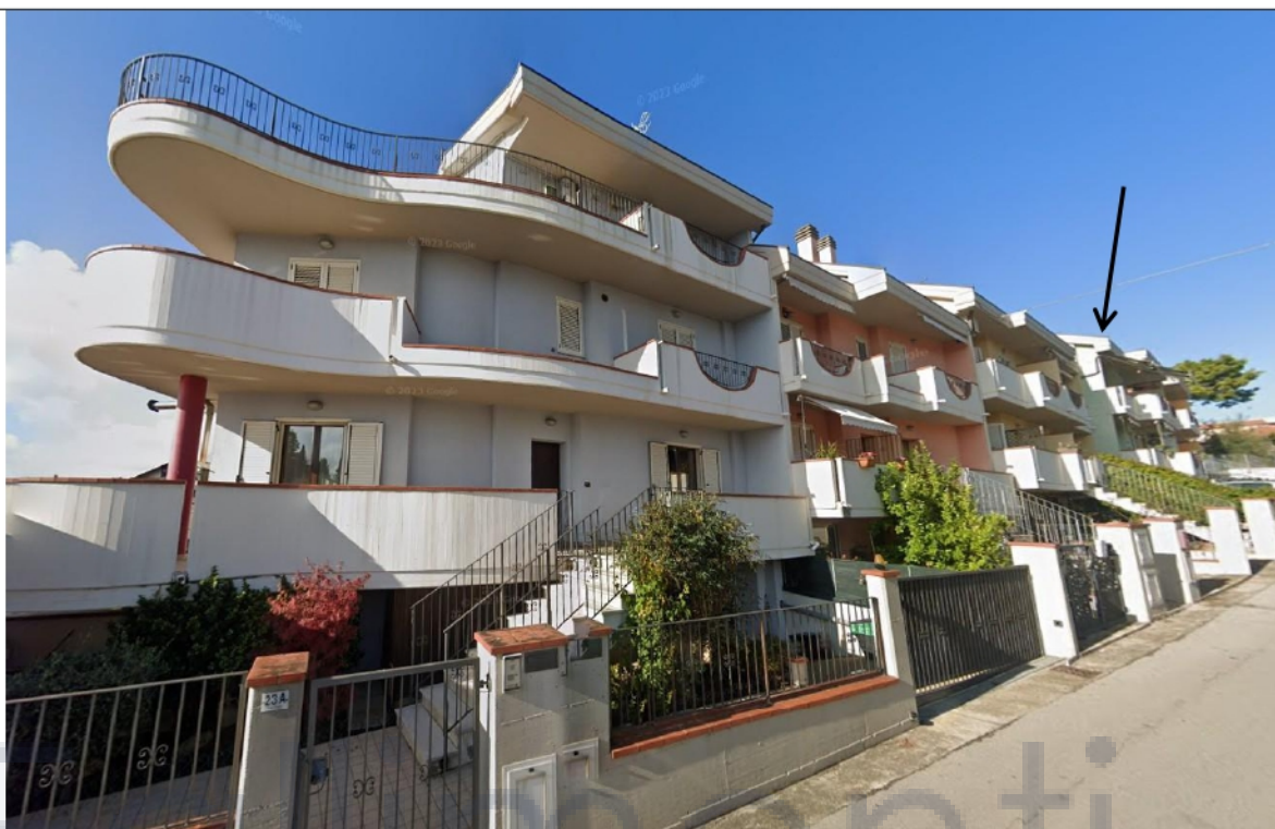
Foto 1 – Vista complesso di case a schiera con individuazione del fabbricato
