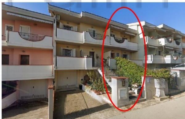
Foto 2 – Vista Edificio da via Prato
