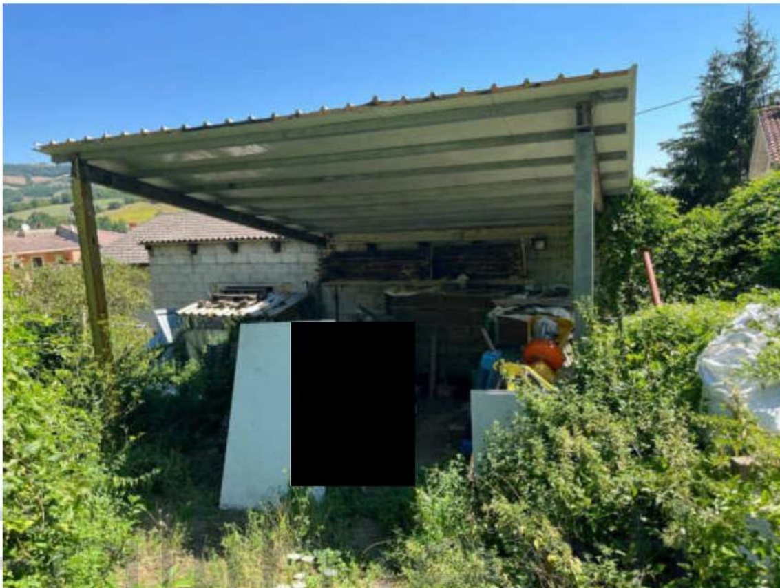
Foto 29 Tettoia posticcia C
