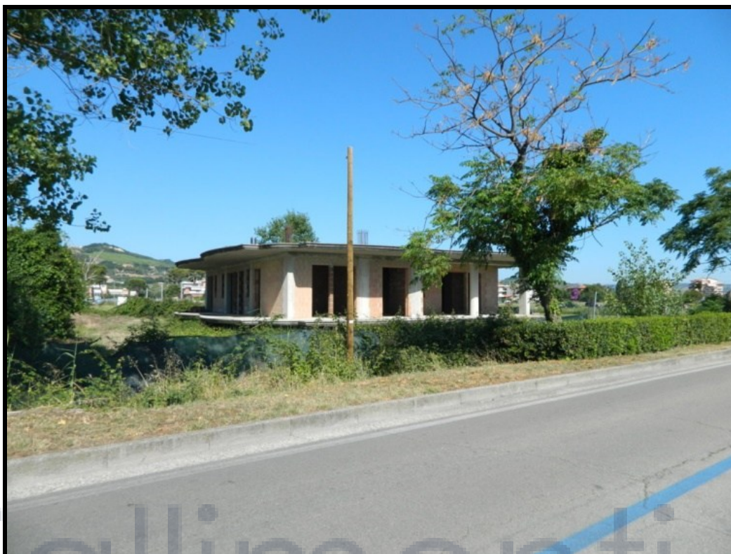
05 – Vista immobile lato Sud-Est
