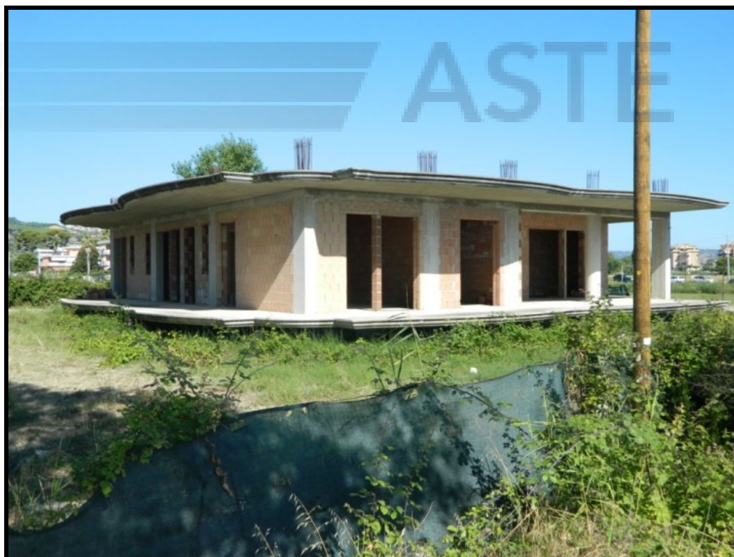
06 – Vista immobile lato Sud
