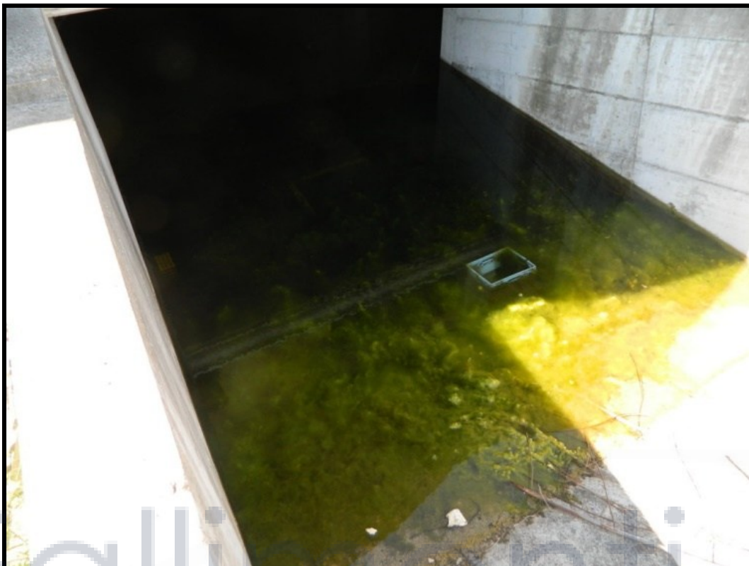
07 – Vista scivolo piano interrato
