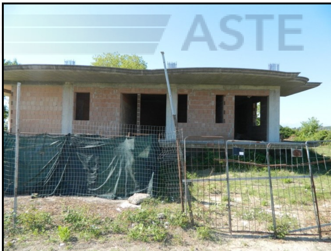
02 – Vista immobile lato Nord
