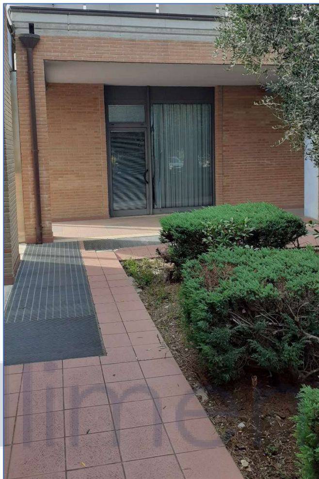
Foto n.1- Accesso al Compendio immobiliare
