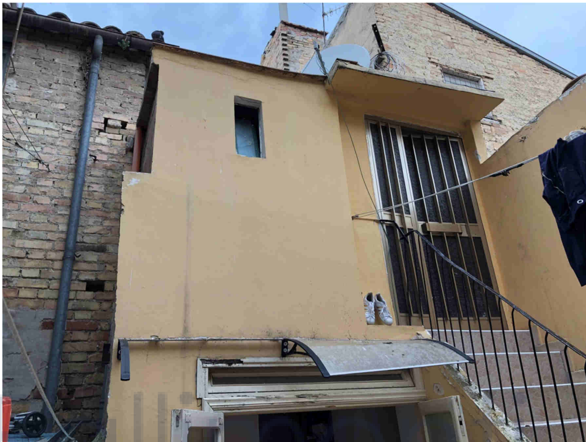
Foto n.9 – Ingresso piano primo
