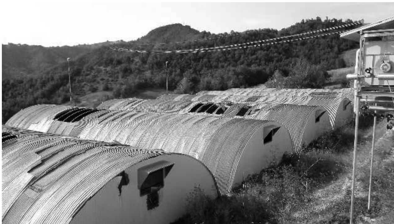
Postazione C : serre ad uso magazzino ( danneggiate )
