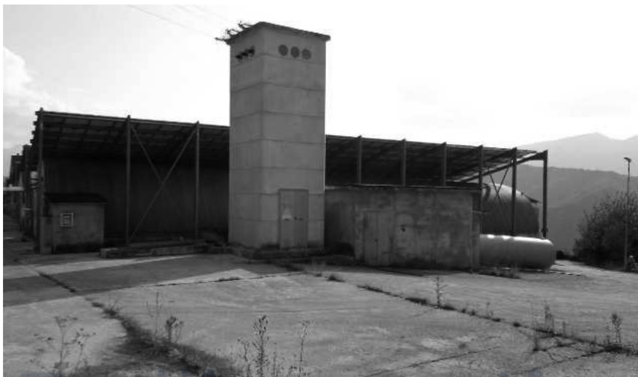
Postazione D : cabina elettrica + centrale termica
