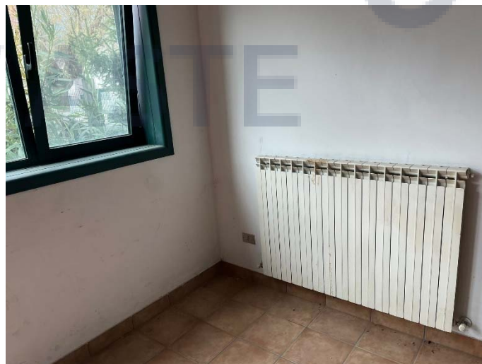
FOTO 92 Vista interno locale mensa
