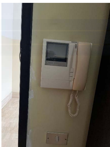
FOTO 123 Vista abitazione P.1°
