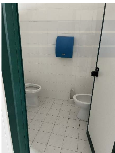
FOTO 99 Vista interno spogliatoio donne
