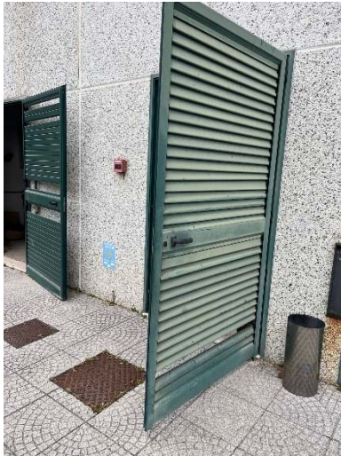
FOTO 21 Vista accesso locale tecnico lato Sud
