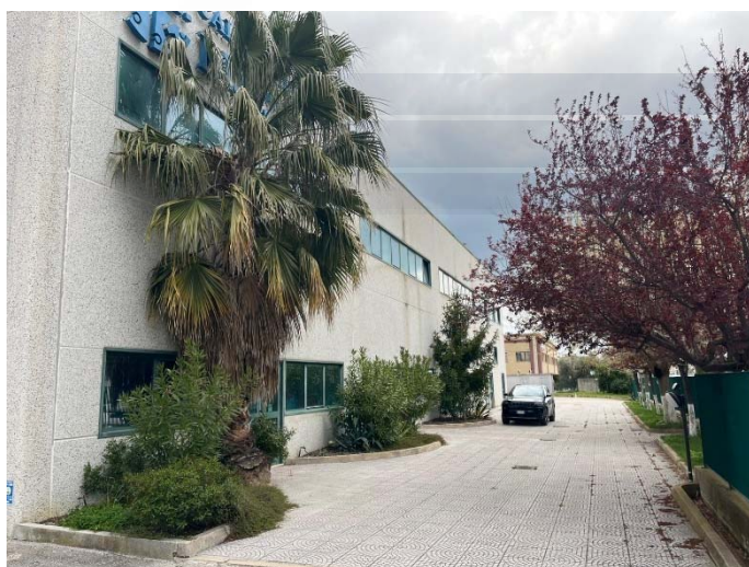
FOTO 15 Vista lato Sud
