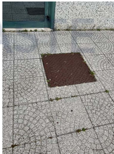
FOTO 24 Vista botola di copertura vasca per impianto antincendio lato Sud
