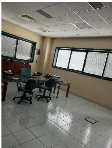
FOTO 45 Vista uffici P.1°
