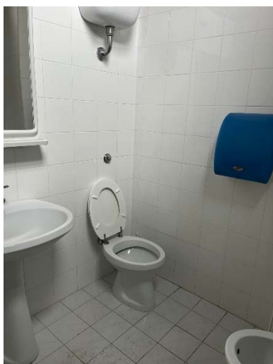
FOTO 97 Vista interno spogliatoio donne
