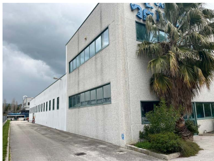
FOTO 14 Vista lato Ovest angolo lato Sud
