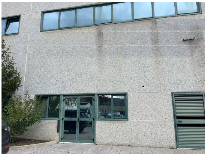
FOTO 19 Vista ingresso mensa lato Sud
