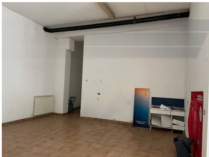
FOTO 91 Vista interno locale mensa
