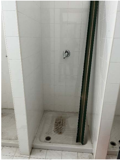
FOTO 101 Vista interno spogliatoio donne
