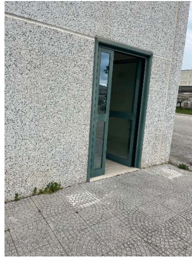
FOTO 22 Vista ingresso P.T. scale lato sud/est per unità abitativa al P.1°
