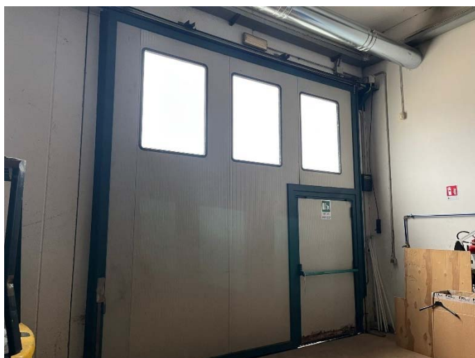
FOTO 77 Vista interno portoncino uscita sicurezza
