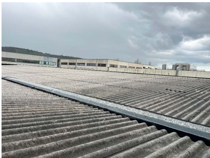
FOTO 125 Vista copertura capannone
