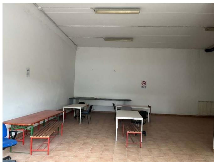
FOTO 90 Vista interno locale mensa
