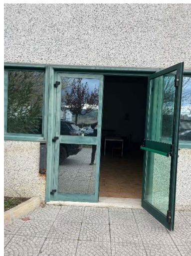
FOTO 18 Vista ingresso mensa lato Sud
