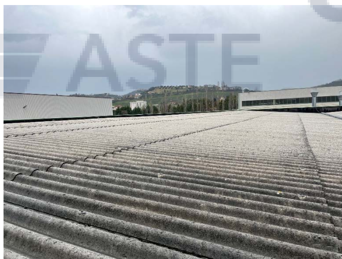
FOTO 124 Vista copertura capannone
